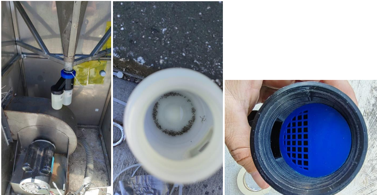
Ilustración 100. Instalación del filtro y resultados. (Elaboración propia)
