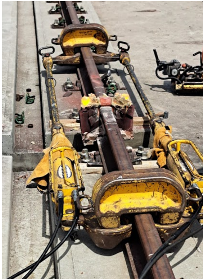
Figura 5.24 Liberación de tensiones mediante el uso de gatos hidráulicos. Tren Interurbano México-Toluca, interestación Zinacantepec-Pino Suárez (septiembre 2022).
