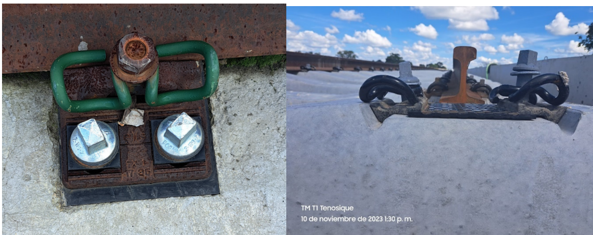
Figura 5.9 Sistema de fijación elástica que se usa en la vía del Tren Maya. Tramo 1 Tren Maya, Tenosique, Tabasco (noviembre 2023)
