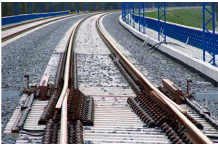
Figura 5.11 Aparato de dilatación tipo Martinet a la salida de un puente en vía sobre balasto. Adaptado de: Aparatos de Dilatación Tipo Martinet (25, septiembre, 2013). Aparatos de Dilatación: Tipos y Criterios Generales de Aplicación. Jose Abadía Almolda. Datos sobre Montaje y Mantenimiento de Vías. pagina. doi: https://hablandodevias.wordpress.com/2013/09/25/aparatos-de-dilatacion-tipo-martinet/
