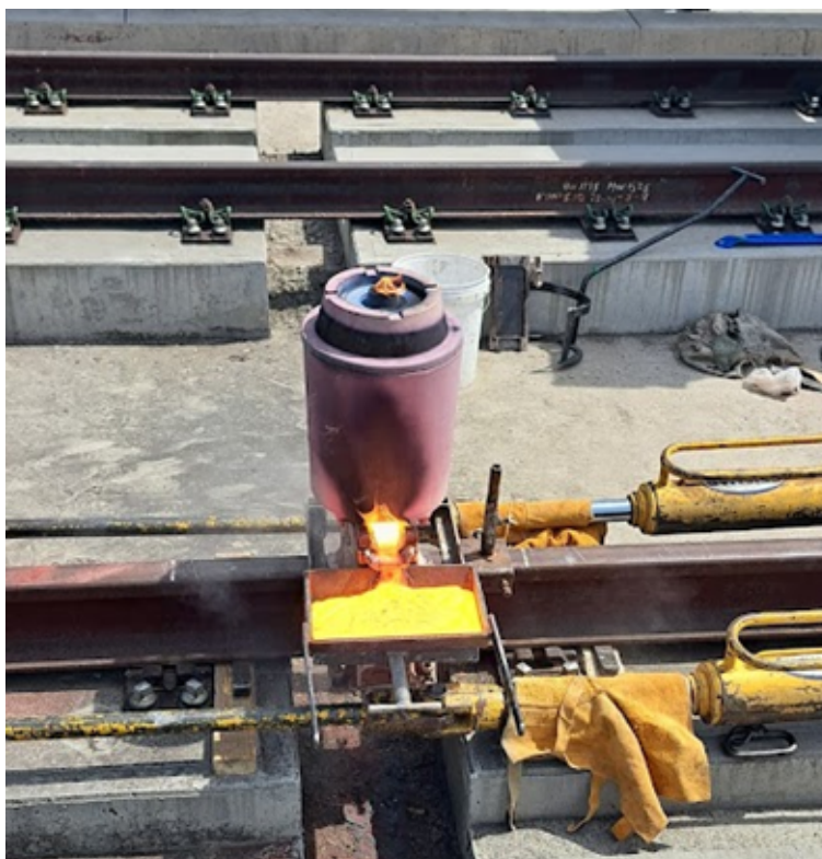
Figura 5.18 Trabajos de soldadura aluminotérmica en proceso de colado de material de aporte después de liberación de tensiones en el Tren Interurbano Mexico-Toluca, interestación Zinacantepec-Pino Suarez. Este procedimiento se llevará a cabo de la misma manera en las vías del Tren Maya (mayo, 2023).
