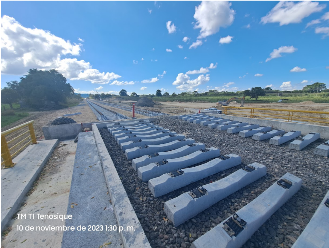
Figura 5.20 Posicionado de durmientes para armado de vía en Tramo 1. Tenosique, Tabasco (noviembre 2023).
