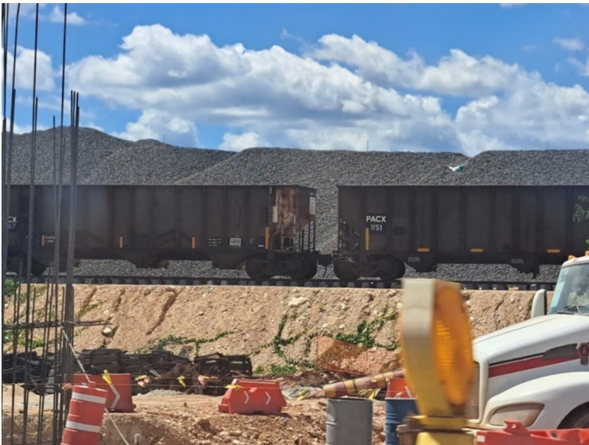
Figura 5.19 Almacenaje y transporte de balasto mediante tolvas balasteras en Tramo 4. Valladolid, Yucatán (octubre 2022).
