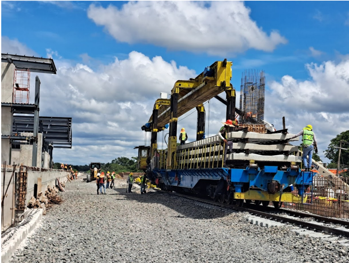
Figura 5.2 Tendido de vía sobre lecho de balasto en Tramo 1 (Procedimiento constructivo por el método de escaleras). (octubre, 2023).
