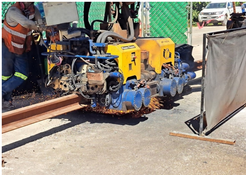
Figura 5.17 Equipo de soldadura eléctrica realizando trabajos de soldeo en rieles del Tramo 4. Nuevo Xcan, Yucatán. (octubre 2022).
