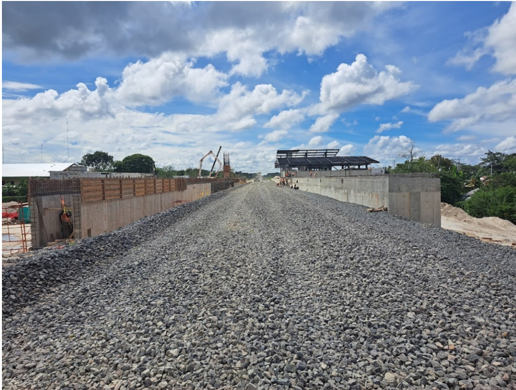
Figura 5.21 Vertido de cama de balasto sobre plataforma de terracerías para el posterior posicionado de durmientes. Tren Maya Tramo 1. Balancán, Tabasco (octubre 2023)
