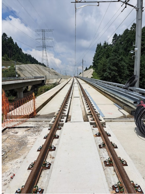
Figura 5.1 Vía en placa en viaducto y terraplén del tren México-Toluca a la entrada del Bi-túnel, dirección Zinacantepec. (agosto 2023).
