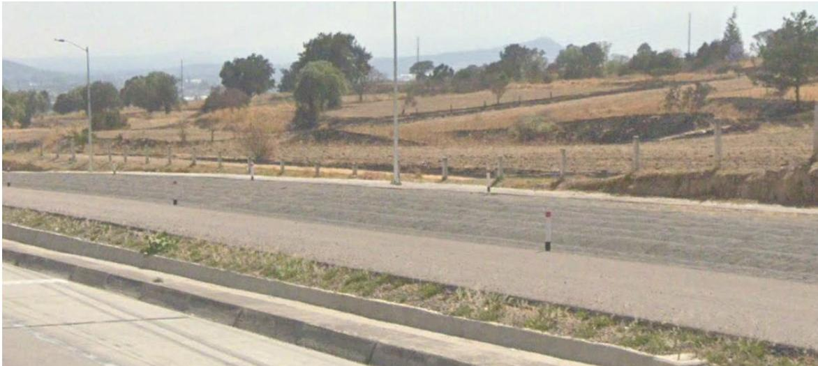
**Imagen 19.** Rampa de emergencia para frenado ubicada en el Libramiento Norte de la CDMX con surcos longitudinales.
