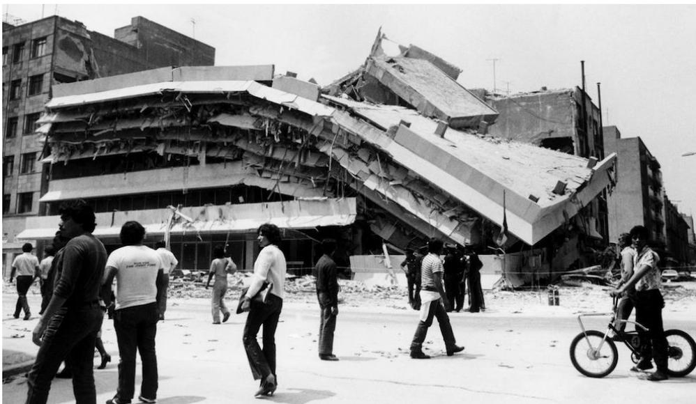
*Figura 2.16 Colapso parcial de edificio en esquina. (Ref. 42)*
