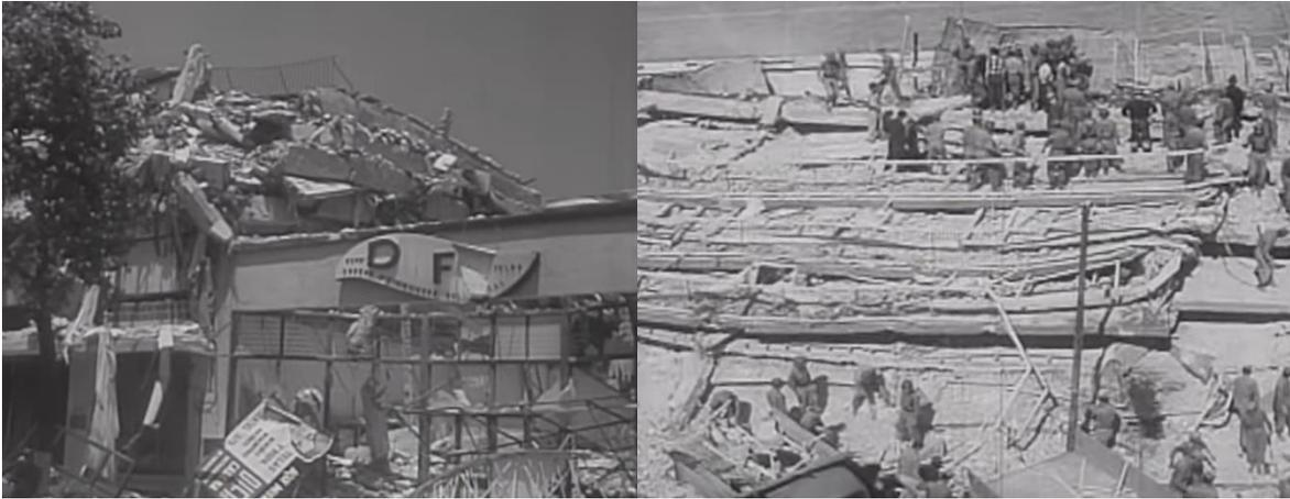
*Figura 2.5 Colapso parcial de edificio de 4 niveles ubicado en Insurgentes y Coahuila y colapso total de edificio de 4 niveles ubicado en Álvaro Obregón (Ref. 27)*
