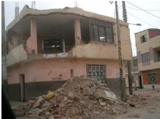
*Figura 4.4 Daños en construcción por efectos de torsión tras sismo en Perú 2007 (Ref. 50)*
