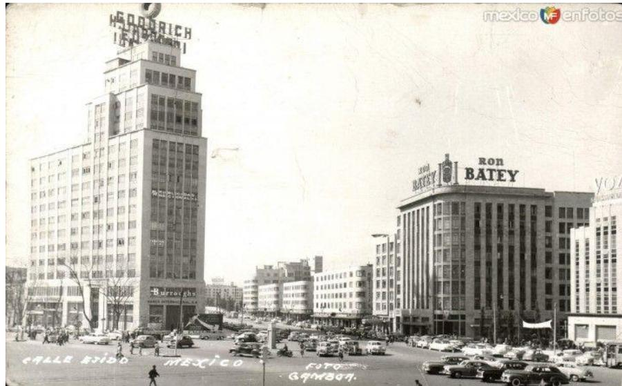
Figura 2.7 Edificio Corcuera, resultó con daños durante el sismo, presenta asimetría en elevación, asimetría en planta y ubicación en esquina. (Ref. 27)
