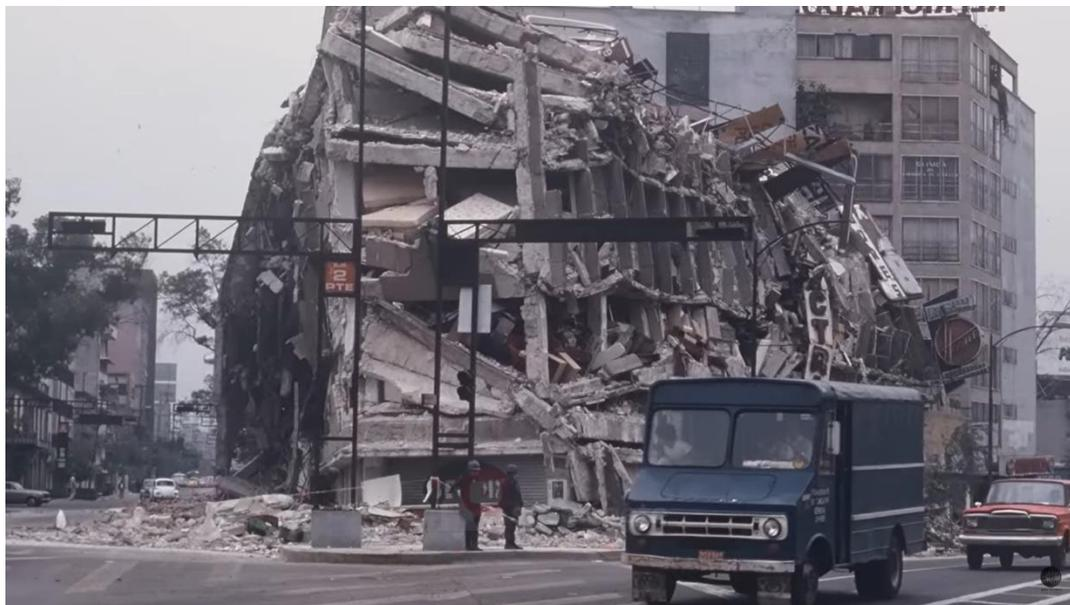
*Figura 2.17 Falla por la combinación de entrepiso débil y efectos de torsión por asimetría en planta. (Ref. 42)*
