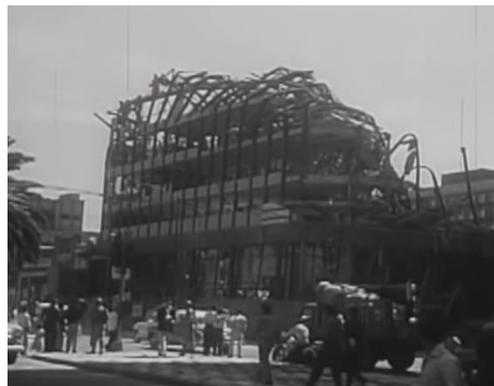
*Figura 2.4 Daño en edificio sobre Paseo de la Reforma (Ref. 16)*
