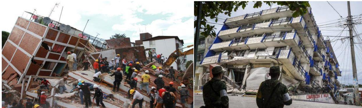
*Figura 2.20 Colapso de estructuras debido al entrepiso débil. (Ref. 43 y 44)*
