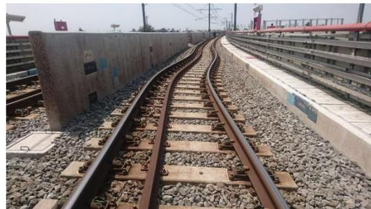
*Figura 1.3 Evidencia de desplazamiento lateral en estructura de línea 12 después del sismo 2017; metro CDMX.(Ref. 38)*
