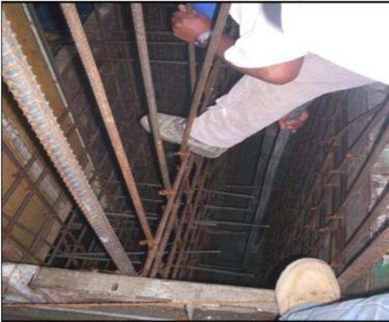
Vibrado de Concreto  $f'c=250\text{kg/cm}^2$
