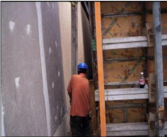
Cimbrado de Muros (accesorios de fijación)
