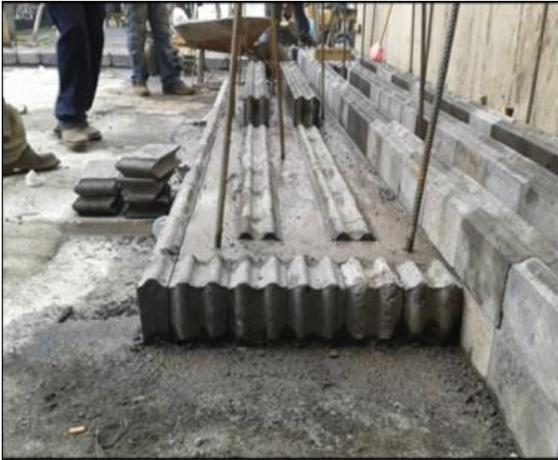
Colado de cadena con grout y Block de Alta Densidad
