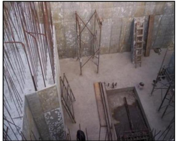
Muros de concreto (barrera primaria bunker)
