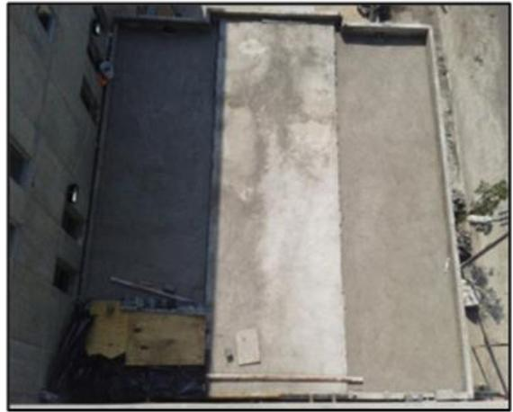
Relleno Fluido en Losa de Cubierta
