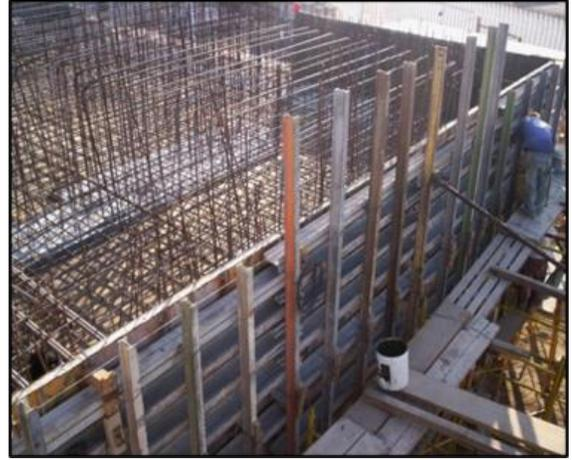
Cimbrado en Muros y Losa Cubierta c/ acero de Refuerzo
