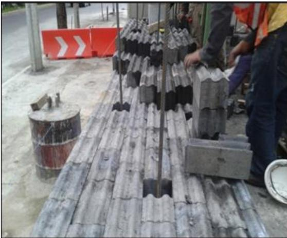
Colocación de hiladas de Block de Alta Densidad
