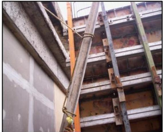
Cimbrado de Muros (accesorios de fijación)
