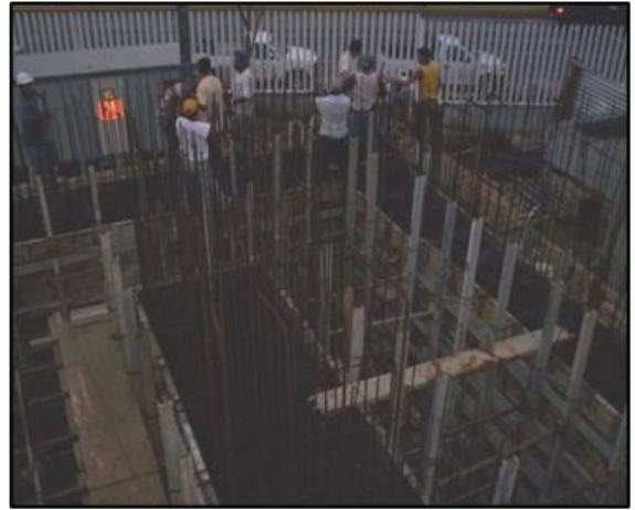
Colado de Muros de concreto  $f'c=250\text{kg/cm}^2$  con bomba telescopica
