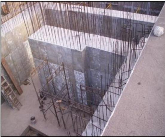
Muros de concreto (barrera primaria bunker)
