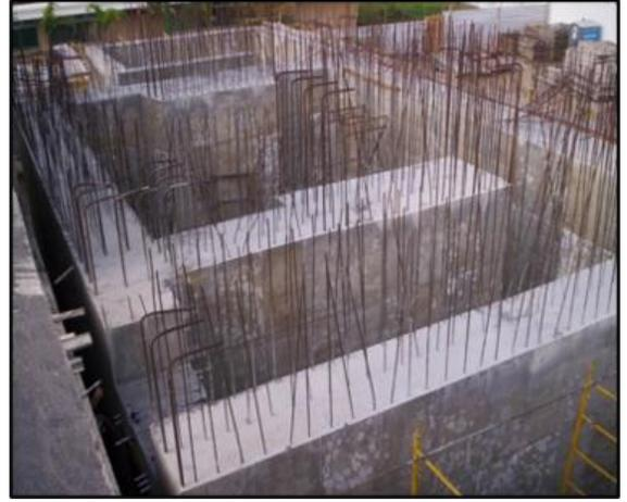
Muros de concreto (barrera primaria y secundaria bunker)
