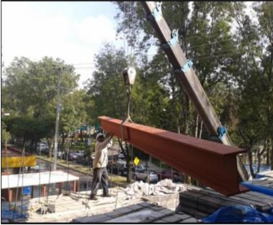
Izaje de Vigas Metálicas para Cubierta
