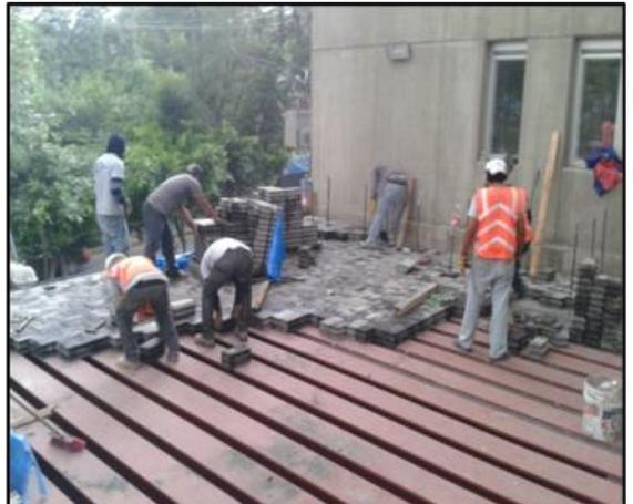
Colocación de Block de Alta Densidad en Losa
