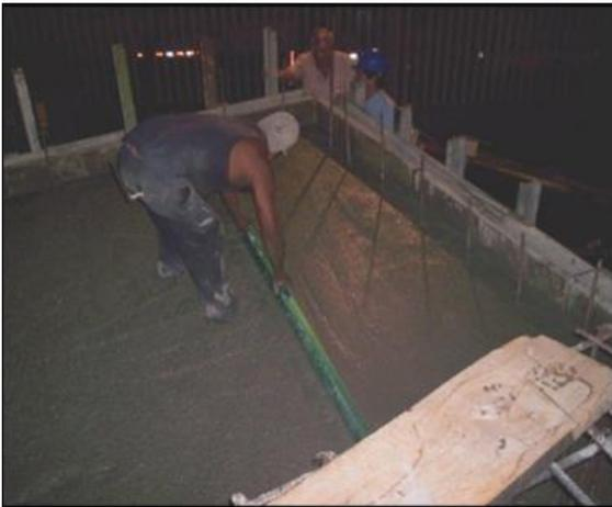
Colado de Losa Cubierta y regleado de concreto
