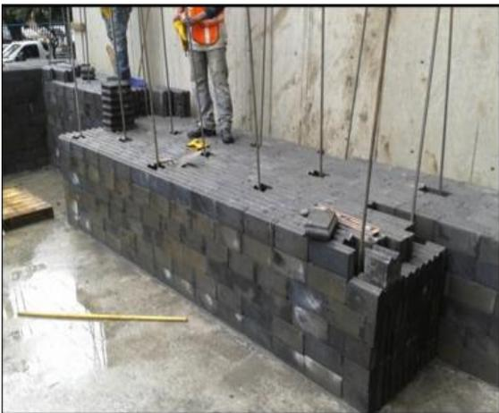
Muro de Barrera Primaria de Block de Alta Densidad
