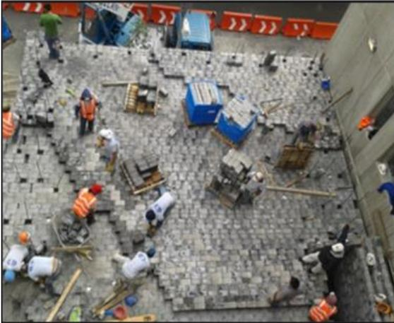
Colocación de Block de Alta Densidad en Losa de Cubierta
