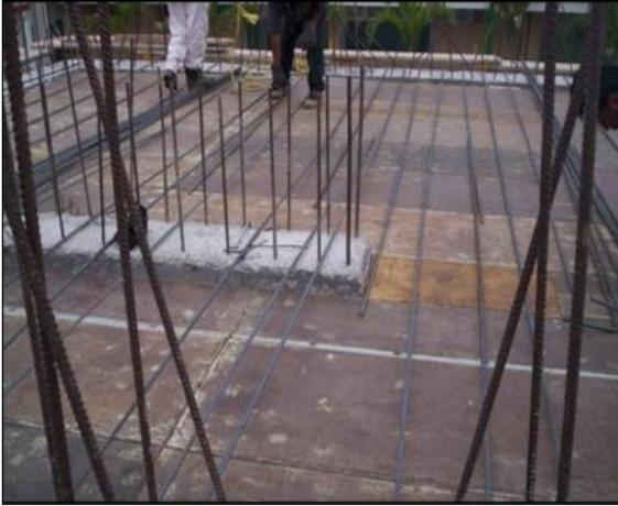
Cimbrado de Losa Cubierta y habilitado de acero de Refuerzo
