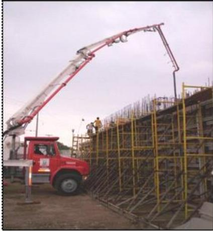
Colado de Muros de concreto  $f'c=250\text{kg/cm}^2$  con bomba telescopica
