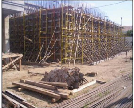
Cimbrado en Muros c/ troquel de puntal metálico
