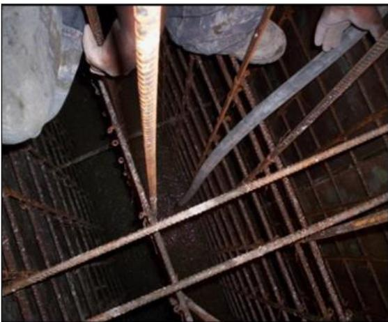
Vibrado de Concreto  $f'c=250\text{kg/cm}^2$
