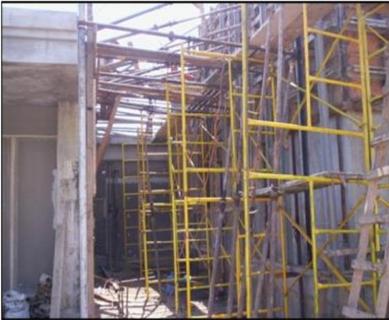
Cimbrado de Muros (accesorios de fijación)
