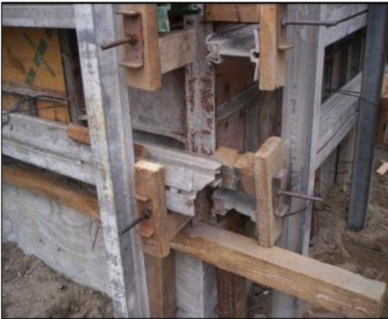
Cimbrado de Muros (accesorios de fijación)
