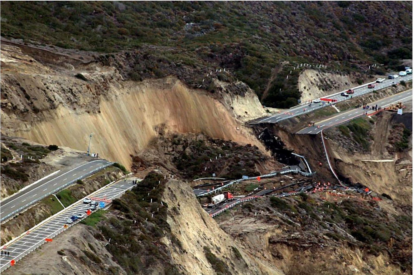
Figura 4. Fotografía del deslizamiento rotacional, generado el 28 de diciembre 2013. Se estimó una masa desplazada de 390 mil m 3 (Tomada de Eroshin, 2013).
