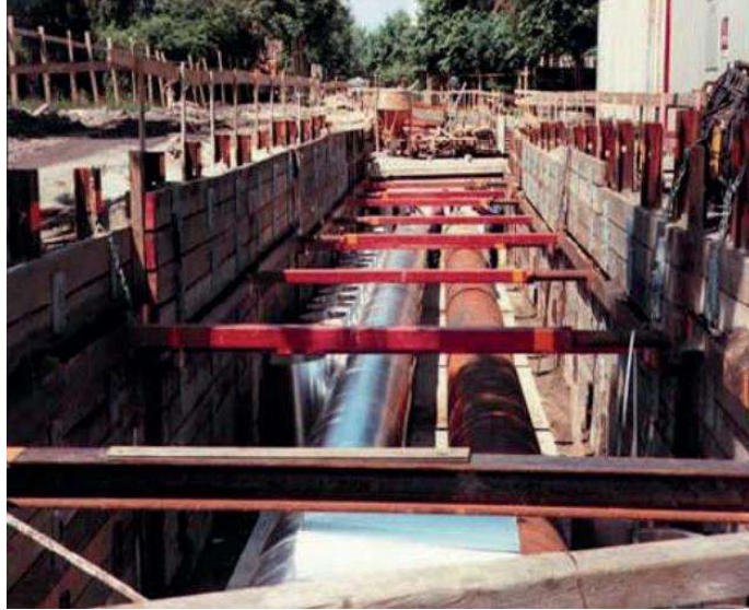
Figura I.7 Muro Berlín con troqueles de acero en excavación para una línea de conducción (Yepes-Piqueras, 2016).
