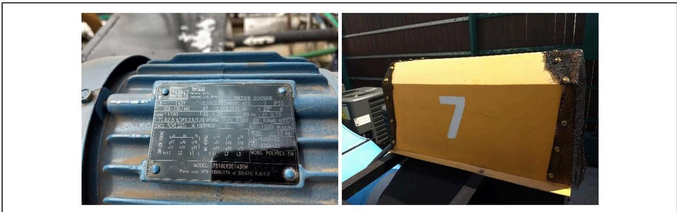
Figura 4.8 Fotografías donde se muestra la placa de datos y estado del motor extractor ubicado en la azotea verde en el caso de estudio
