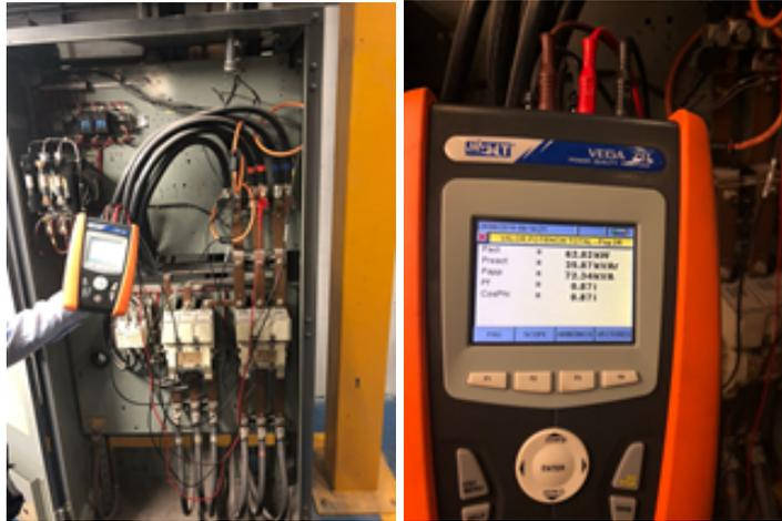
Figura 4.6 Fotografías donde se muestra la medición de los parámetros eléctricos de los equipos *Chiller* dentro de la fosa de máquinas en basamento en el caso de estudio
