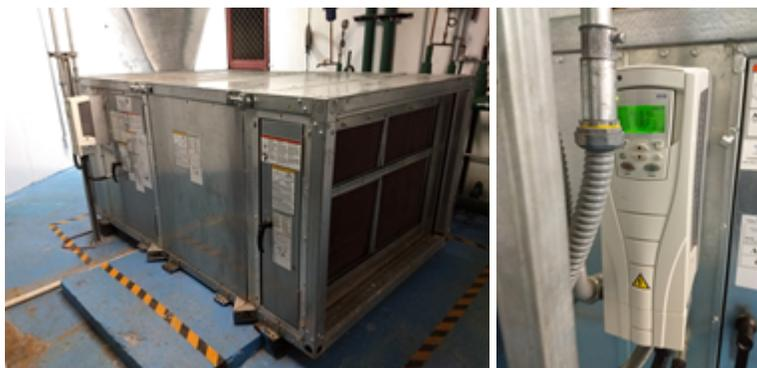
Figura 4.7 Fotografías donde se muestra el sistema de control de los UMA con variador de frecuencia que se encuentra en todos los pisos en el caso de estudio
