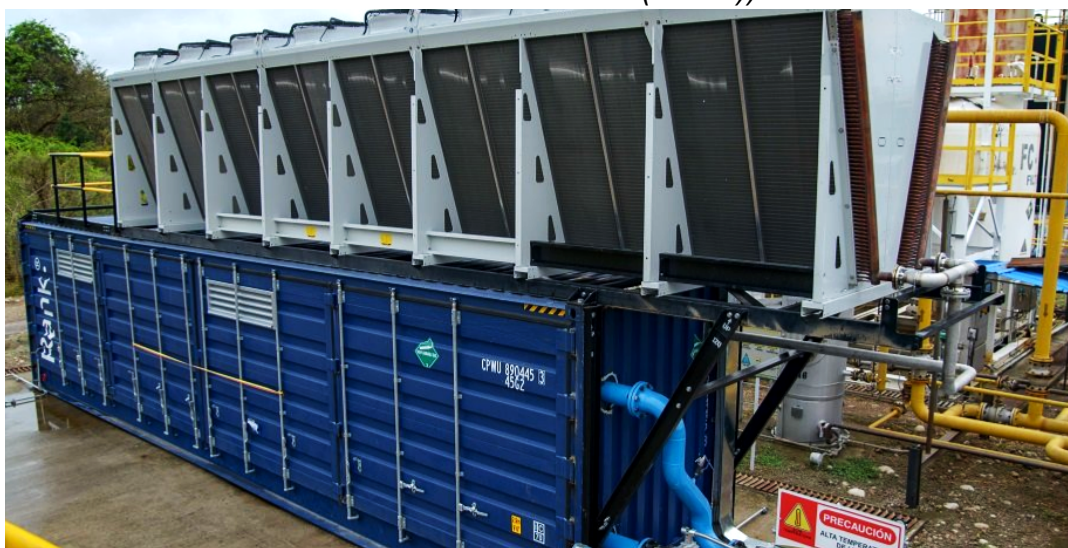
Figura 49. Planta de ciclo binario con refrigeración para coproducción, en campo Maracas, en Casanare, Llanos Orientales, Colombia (Parex Resources Inc. y Universidad Nacional de Colombia (UNAL)).
