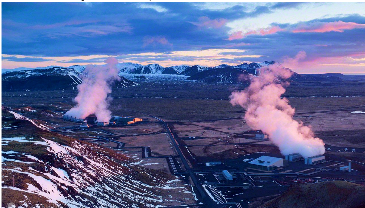
Figura 1. Central geotérmica de Hellisheiði, Islandia.
