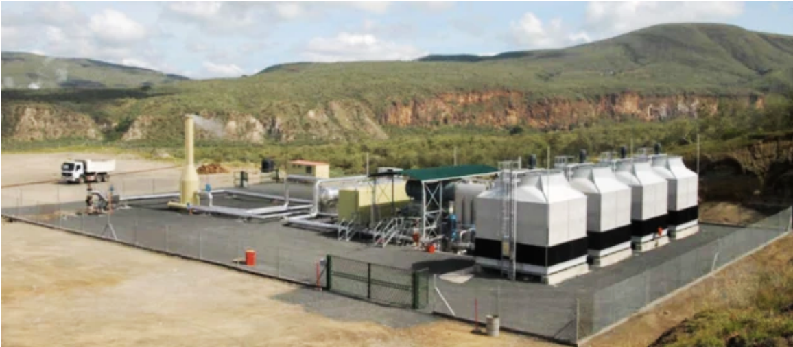
Figura 17. Planta de energía en cabeza de pozo (5 MW) en Olkaria, Kenia.
