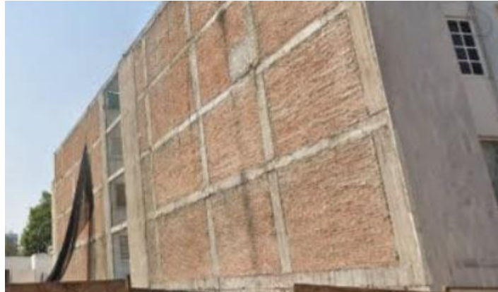
Figura 3. Ejemplo de muro diafragma. Obtenido de: https://photos.app.goo.gl/7Tkwt0aTL6HQBkU43
