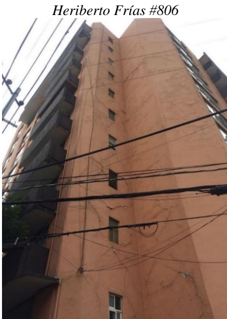
Figura 36. Fallas por tensión diagonal en muros no estructurales en los edificios estudiados
