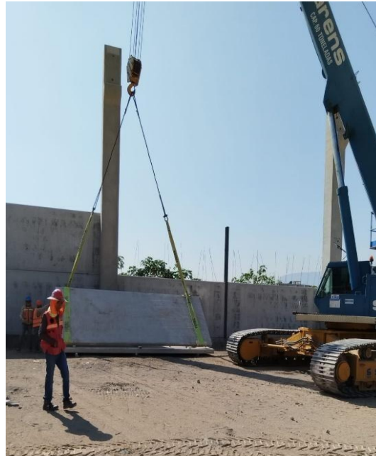
Ilustración 29. Izaje de los muros spancrete para el montaje final.
