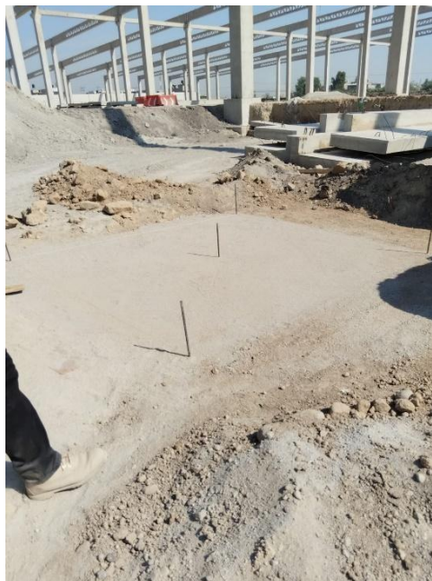
Ilustración 55. Mejoramiento de suelo realizado.
