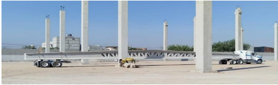
Ilustración 12. Traslado de traveses delta a sitio de la obra.
