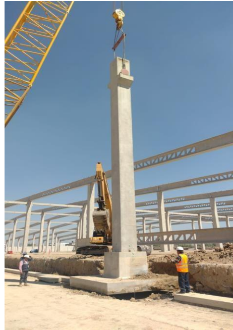
Ilustración 54. Izaje de la zapata y columna juntas.
