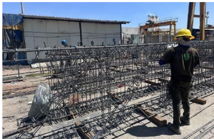
Ilustración 4. Armado de acero acorde a planos de ingeniería.
