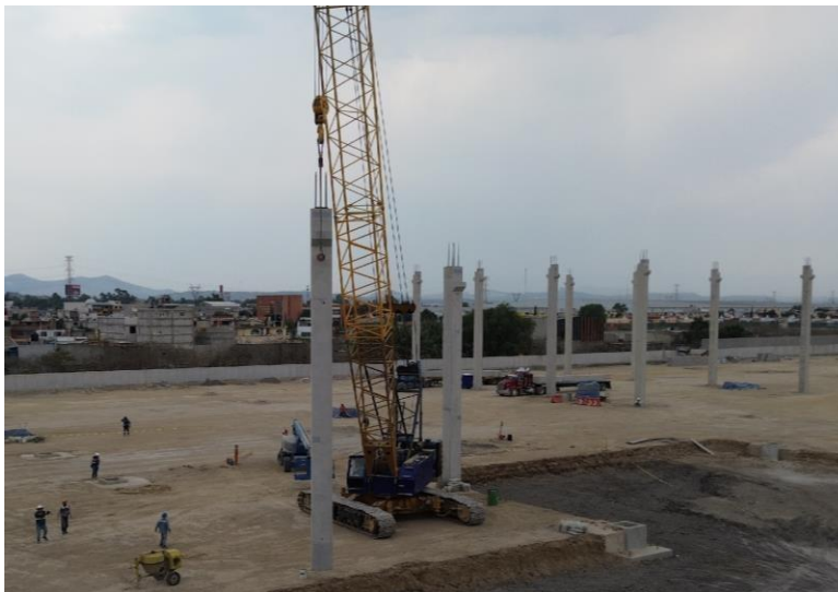
Ilustración 22. Izaje de columnas prefabricada para el montaje final.
