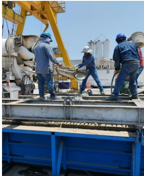
Ilustración 6. Colado del elemento prefabricado.
