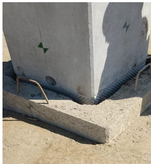
Ilustración 21. Unión de zapata prefabricada con columna prefabricada.
