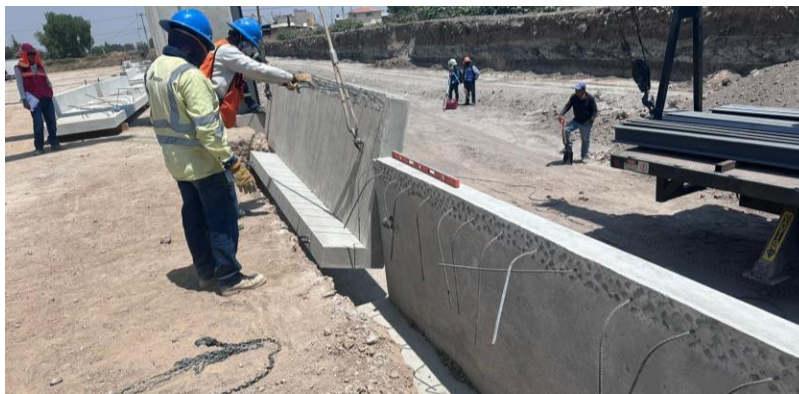
Ilustración 19. Izaje de las zapatas corridas prefabricadas para el montaje final.
