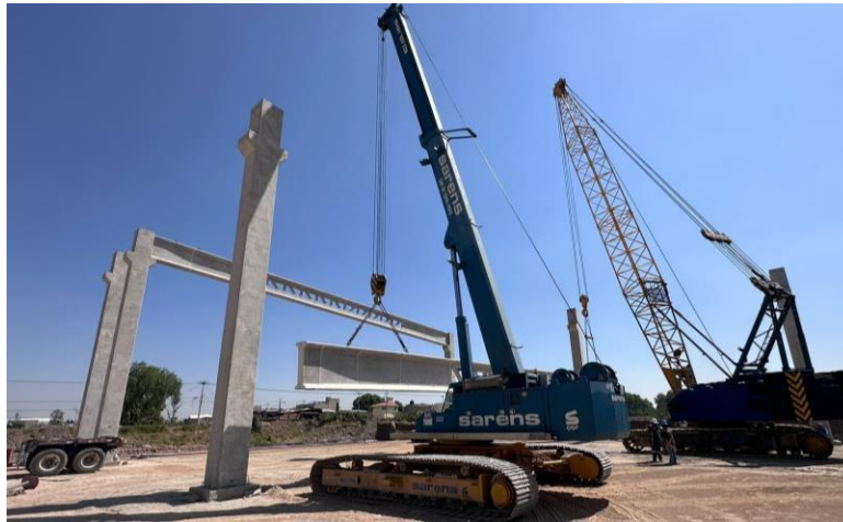
Ilustración 25. Izaje de traves tipo "I" para el montaje final.
