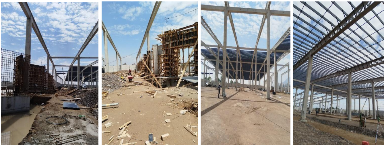
Ilustración 56. Trabajos subsecuentes al armado de la estructura con elementos prefabricados.
