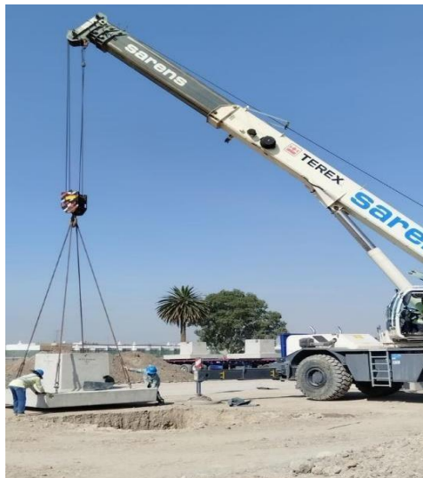
Ilustración 17. Izaje de las zapatas aisladas para el montaje final.
