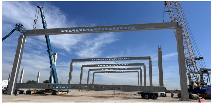
Ilustración 14. Izaje de las traves tipo "I" prefabricadas para el montaje final.
