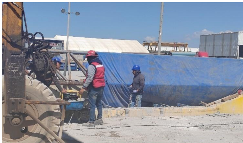
Ilustración 7. Correcto enlonado para el curado del elemento prefabricado.
