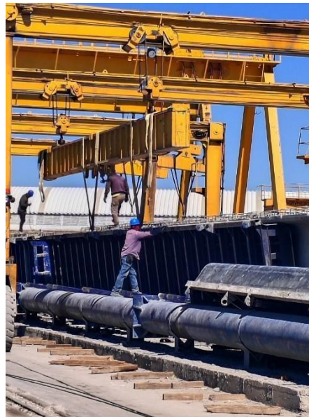
Ilustración 8. Extracción de elemento prefabricado.
