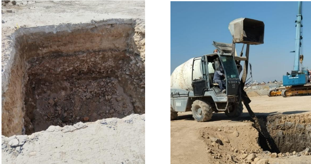
Ilustración 16. Preparación de terreno y colocación de suelo-cemento.
