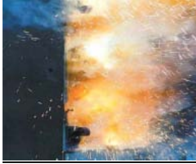
Figura 2.1 Explosión causada por un arco eléctrico
