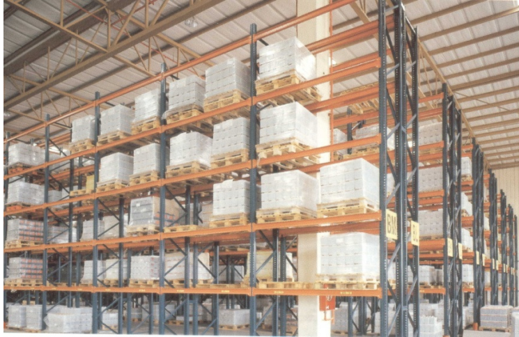
FIGURA 16 MÓDULO DE RACKS SELECTIVOS
