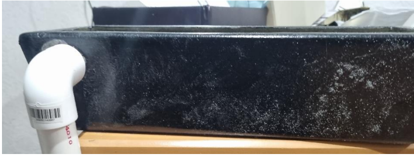
Figura 32 Reservorio de agua con codo de 1" de PVC
