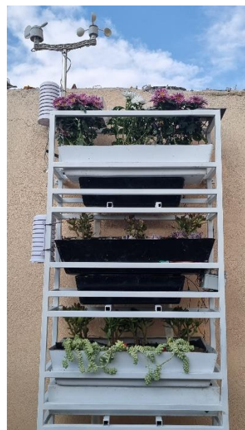
Figura 60 Módulo de sistema de muros verdes finalizado
