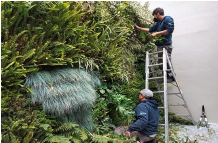
Figura 4 Mantenimiento de muros verdes de Generación verde. Obtenido de: http://tinyurl.com/z7tvzxda
