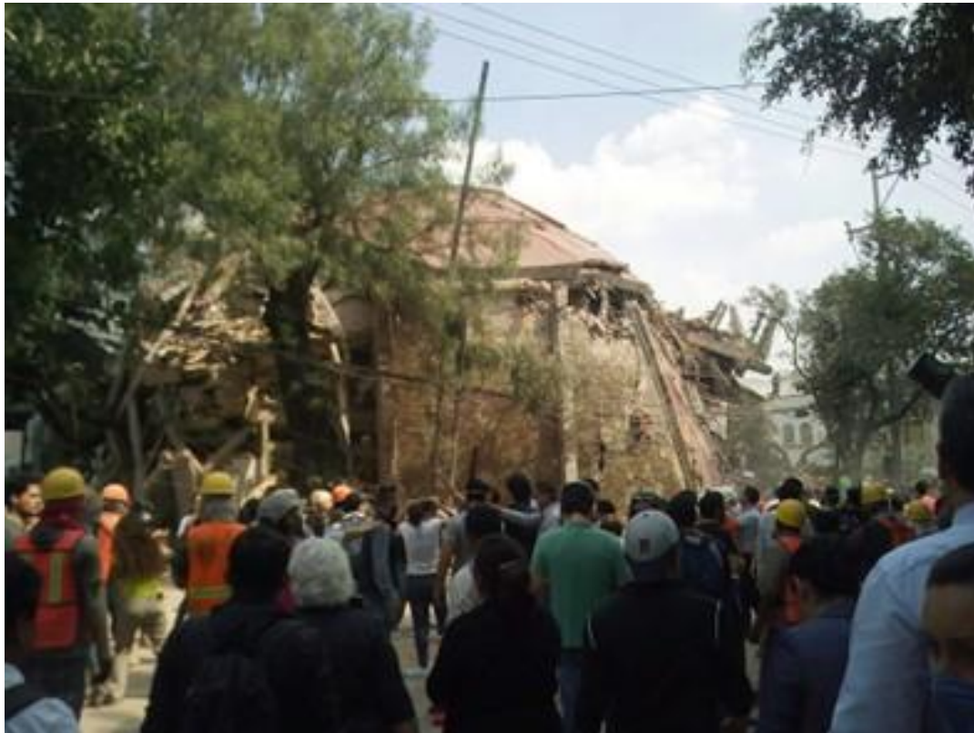
Ilustración 12 Estructura colapsada Fuente propia
