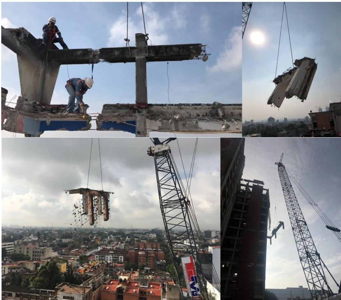
Ilustración 39 Seccionamiento y retiro de elementos. Fuente Propia
