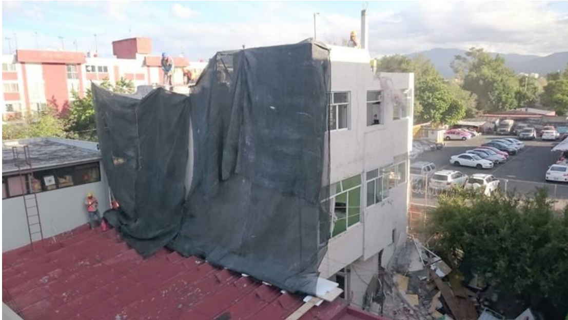
Ilustración 25 Primeras protecciones a inmuebles aledaños Fuente Propia
