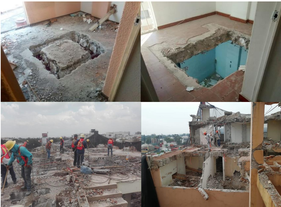
Ilustración 40 Demolición manual y vaciado de material a niveles inferiores Fuente Propia
