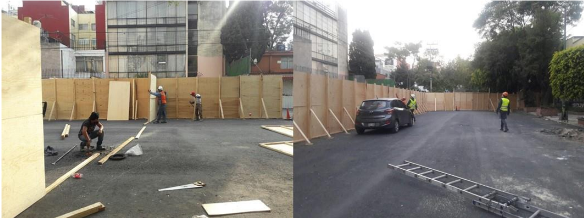
Ilustración 32 Confinamiento del área a utilizar durante la demolición. Fuente Propia
