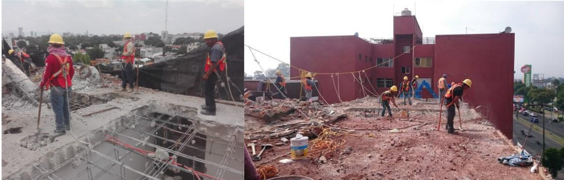
Ilustración 42 Ejemplo de primeras líneas de vida y sujeción ocupadas Fuente Propia
