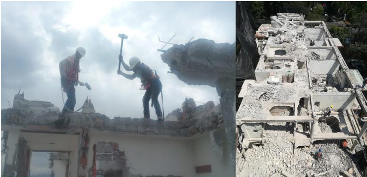
Ilustración 30 Ejemplo de demolición de losas Fuente Propia
