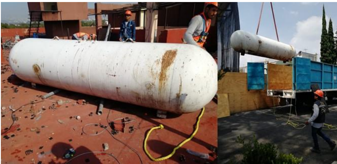
Ilustración 38 Retiro de tanques estacionarios. Fuente Propia
