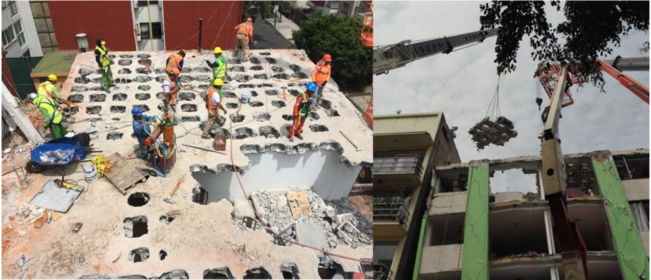
Ilustración 31 Ejemplo de demolición de losas Fuente Propia
