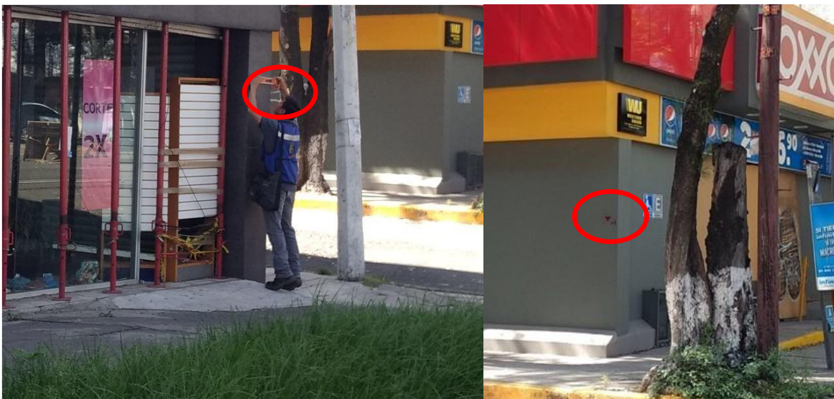
Ilustración 28 Colocación de niveles de control Fuente Propia
