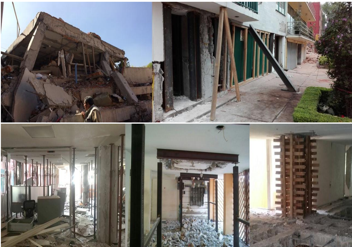
Ilustración 29 Ejemplos de aseguramiento de elementos Fuente Propia
