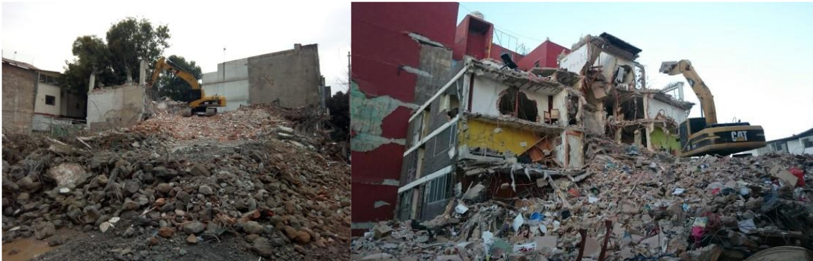
Ilustración 41 Demolición sobre banco de material con producto de los trabajos Fuente Propia
