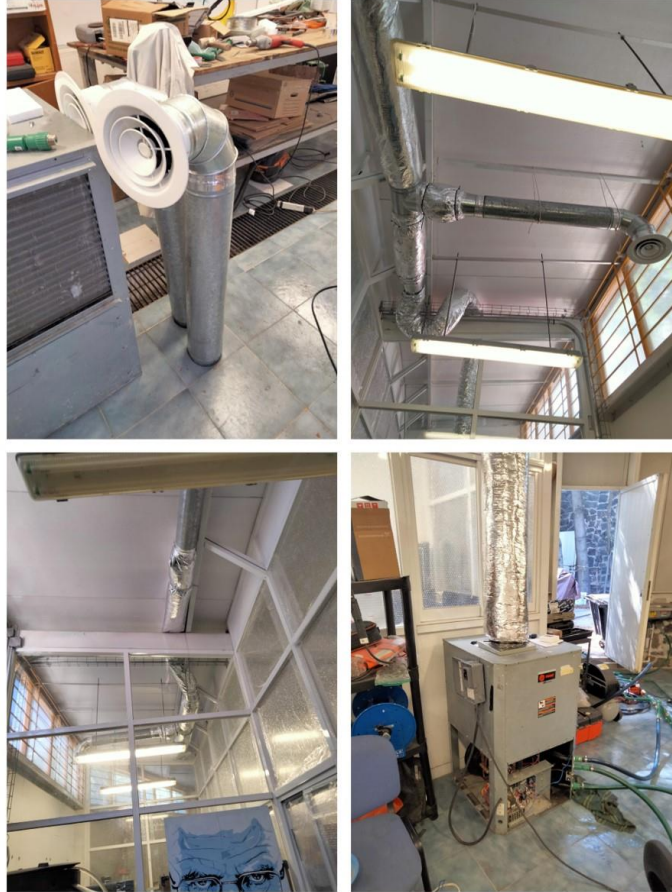
Ilustración 27. Instalación de ductos
