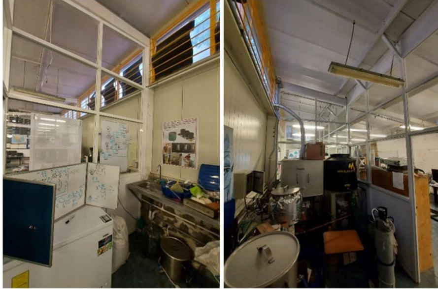
Ilustración 15. Sección de laboratorio de cerveza artesanal antes de mejoras de aislamiento térmico
