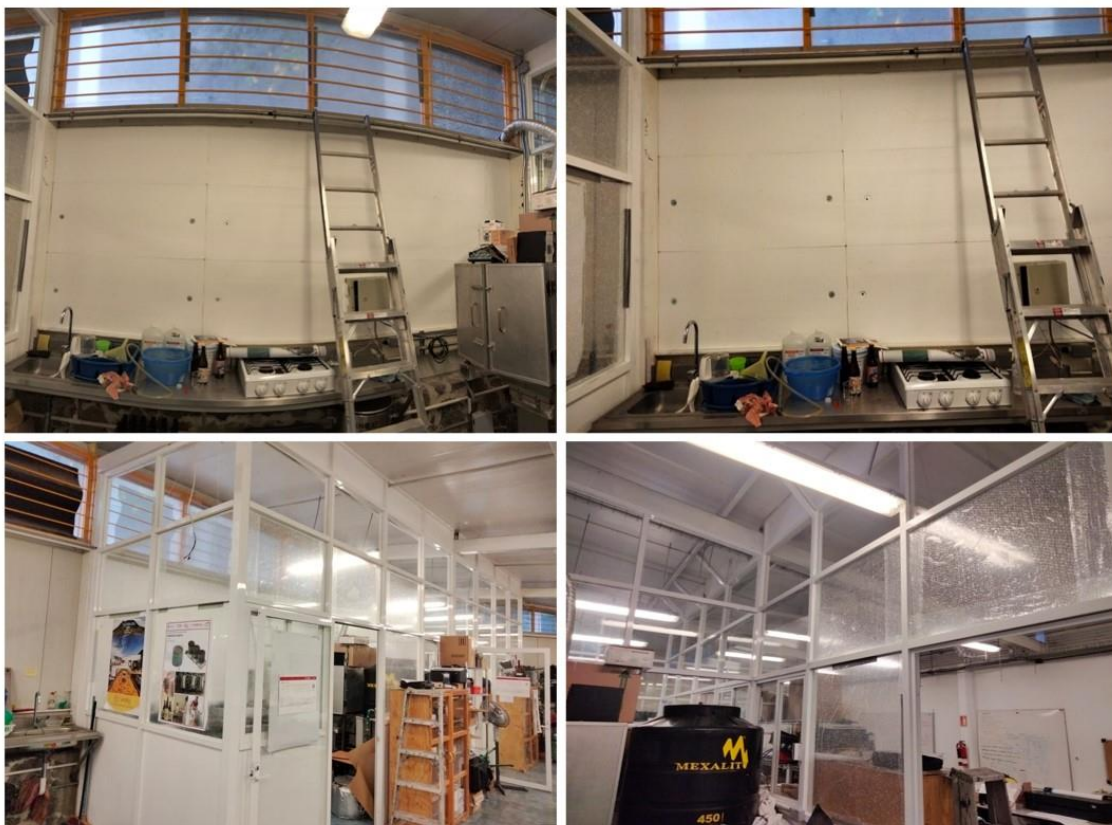
Ilustración 18. Aislamiento con plástico burbuja y placas de poliestireno
