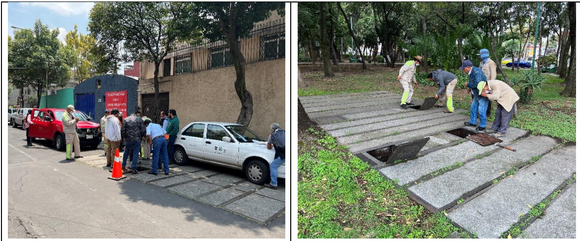
FIGURA 34 RECORRIDOS DE VERIFICACIÓN DE INFRAESTRUCTURA SOBRE LA RED PRIMARIA
