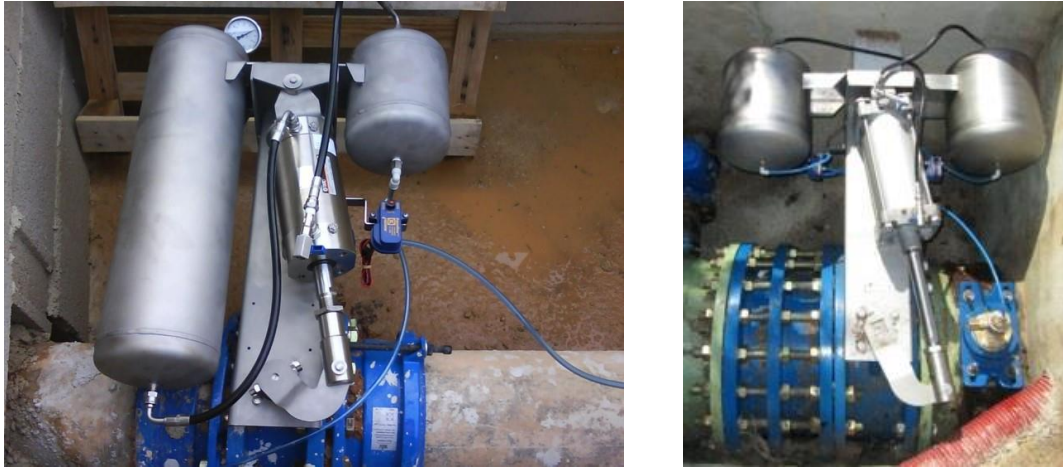
FIGURA 47 INSTALACIÓN DE ACTUADORES HIDRÁULICOS SOBRE VÁLVULAS DE MARIPOSA.
