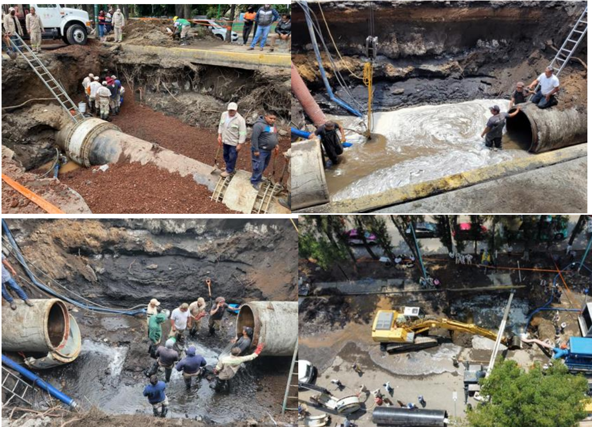
FIGURA 46 REPARACIÓN DE FUGA EN AV. SAN LORENZO Y CALLE ESTRELLA.
