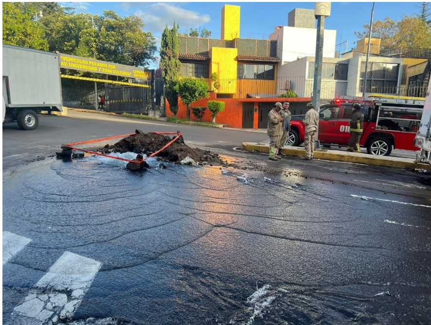
FIGURA 2 FUGAS EN LA RED DE DISTRIBUCIÓN DE AGUA POTABLE
