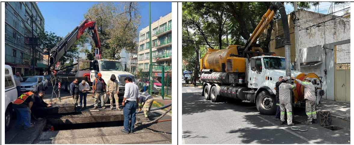
FIGURA 35 RETIRO DE MARIMBAS Y DESAZOLVE DE CAJAS DE RED PRIMARIA
