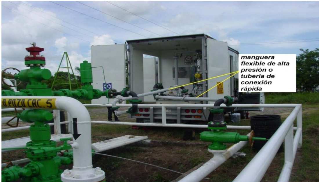
Figura IV.1 Conexión de la unidad móvil con manguera flexible de alta presión o con tubería de conexión rápida.
