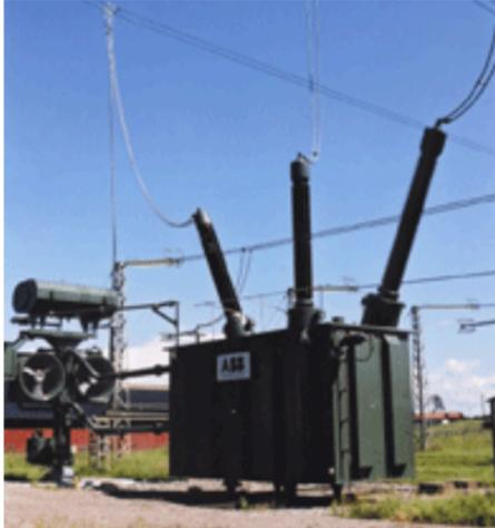
En la subestación de la planta se usan en el neutro de los transformadores para limitar la corriente de cortocircuito a tierra. En algunas ocasiones se utilizan en serie con cada una de las tres fases de algún transformador, para limitar la corriente de cortocircuito trifásico.
