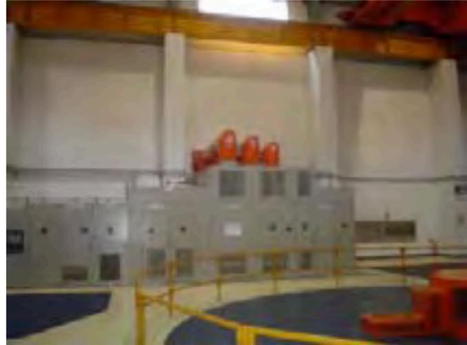
**Figura. 3.27 Salida de buses del generador.**
