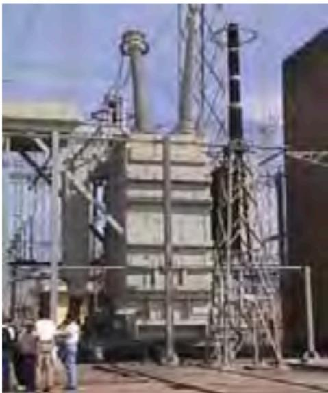
Estos transformadores al igual que los de corriente, se fabrican con aislamientos de resinas sintéticas para tensiones bajas o medias, mientras que para las altas tensiones se utilizan aislamientos de papel, aceite y porcelana.
