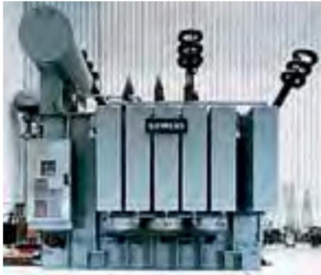
Un transformador es una máquina electromagnética, su función principal es cambiar las tensiones eléctricas, en nuestro caso, levantan el nivel del potencial a un valor adecuado para su transmisión.
