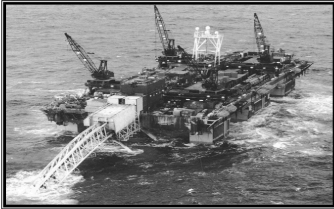
Figura III.5 Tendido de la tubería con barcaza convencional
