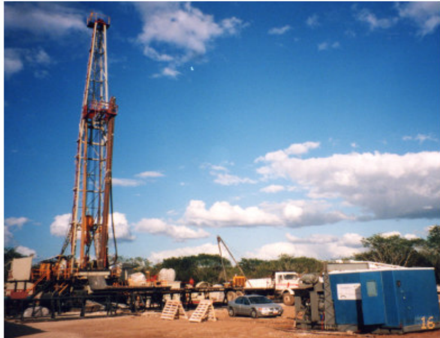
Fig.3.7 Se muestra el equipo de perforación tanto como la cabina que se utilizo para la recolección de datos
