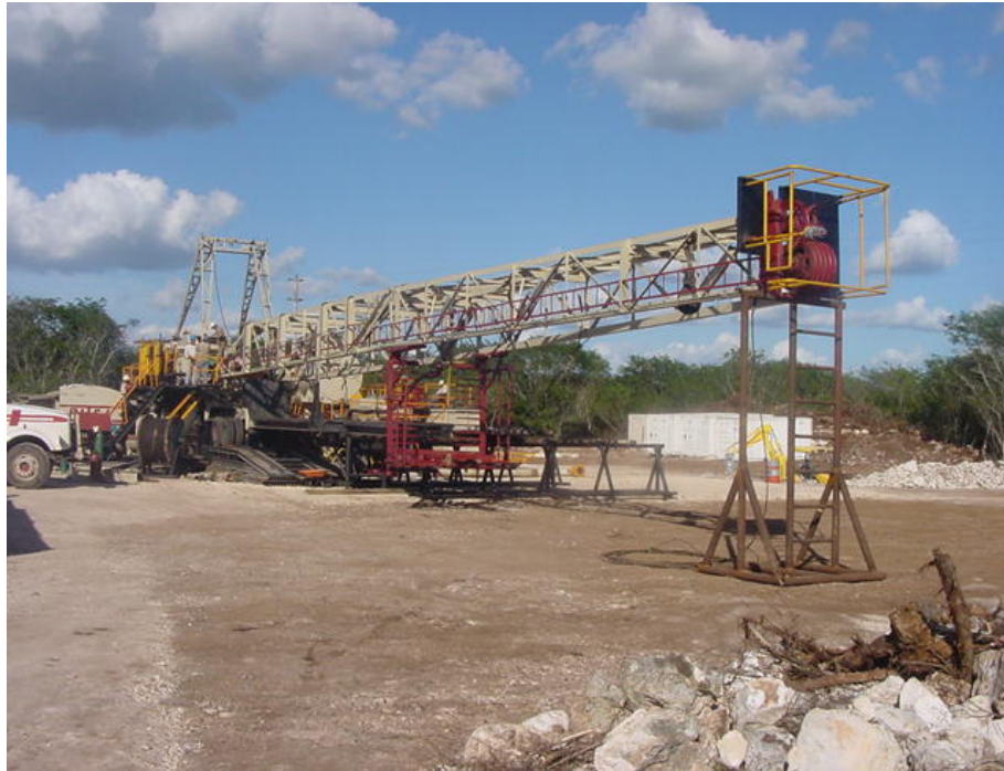
Fig.3.11 En la ilustración se muestra el momento en el cual se estaba levantando la torre de perforación
