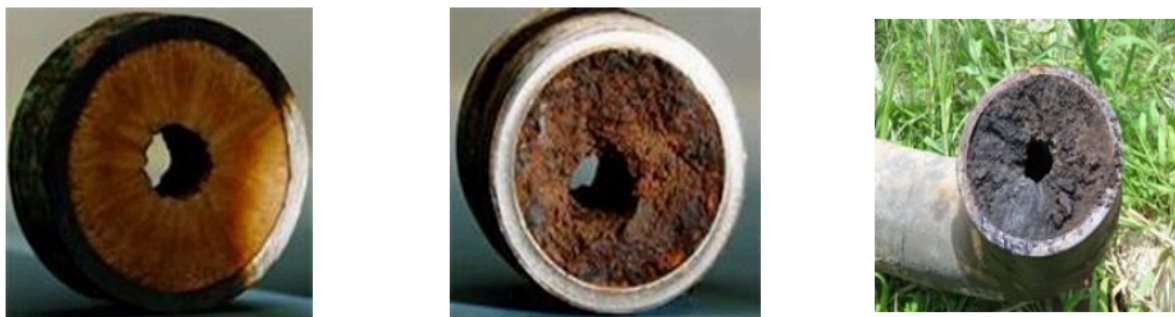
fig. III.1 Incrustaciones orgánicas e inorgánicas debidas a la presencia de parafinas, resinas y asfaltenos.
