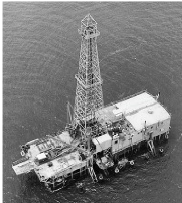
FIG I.1 Barcaza de perforación Propiedad Offshore magazine
