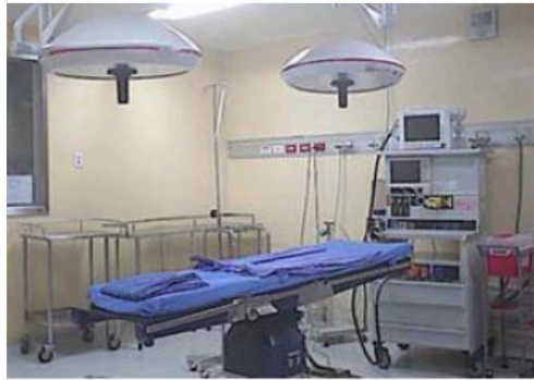
Fig. 2.8 Sala de operaciones.
