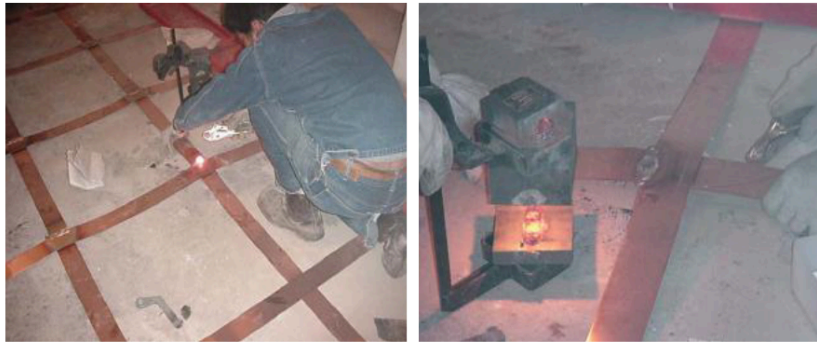
Fig. 4.9 Colocación de piso semiconductor.
