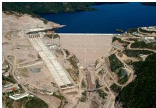
Figura 2. Foto de los vertedores de la presa hidroeléctrica del Cajón.
