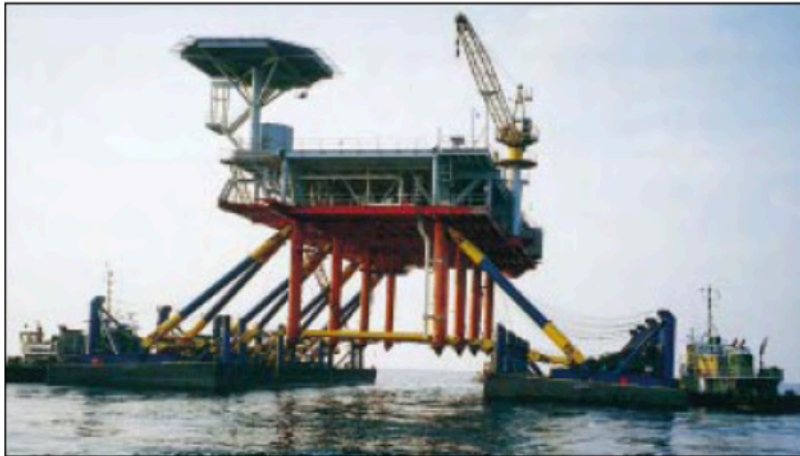
Figura 5.6-3 El sistema Versatruss elimina la necesidad de grandes grúas y barcasas. (Tomado de Oilfield Review, Schlumberger 30 , 2007).
