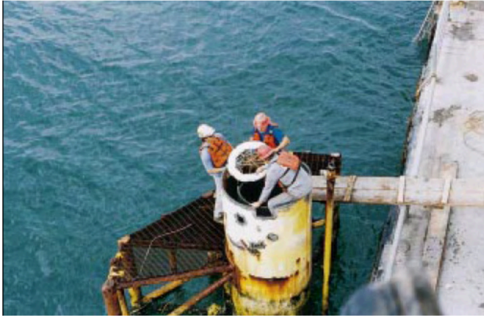
Figura 5.6-5 Especialistas en explosivos instalando el dispositivo en uno de los pilares de una plataforma en el Golfo de México (Tomado de Oil & Gas Journal 46 , 1997).
