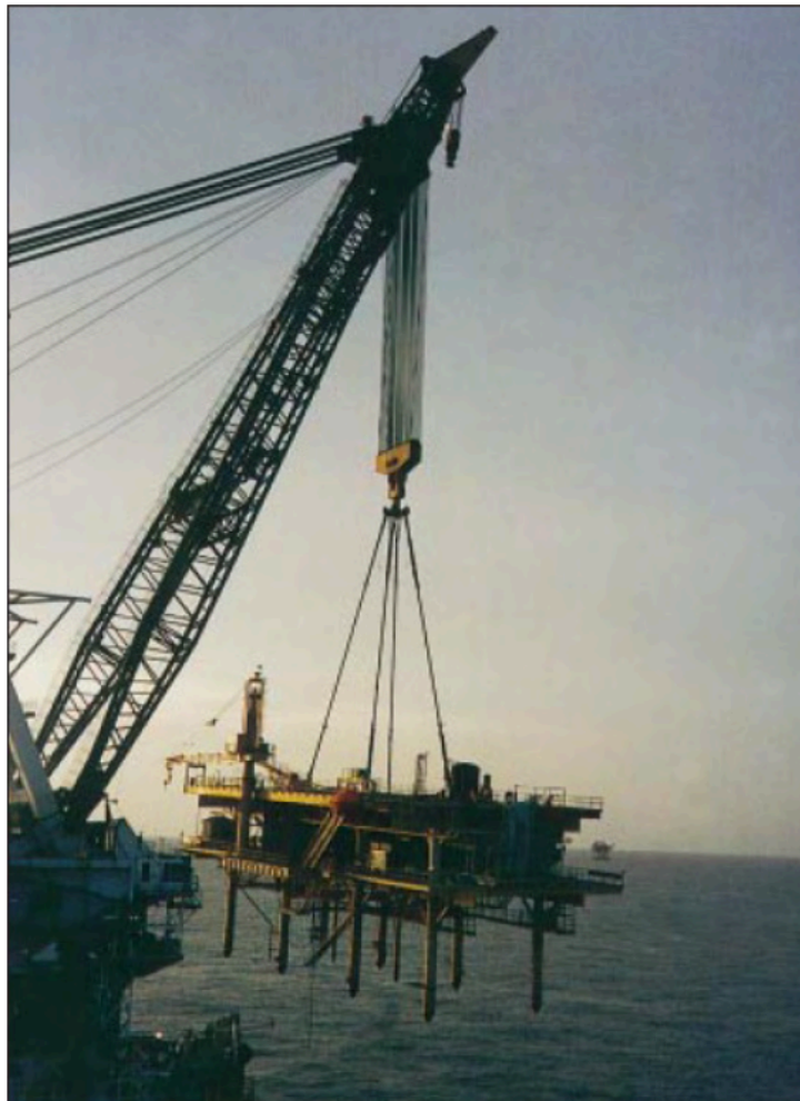
Figura 5.6-2 Una grúa gigante levanta la cubierta de una plataforma previamente derrumbada que servirá de arrecife artificial en el Golfo de México (Tomado de Oilfield Review, Schlumberger 30 , 2007).
