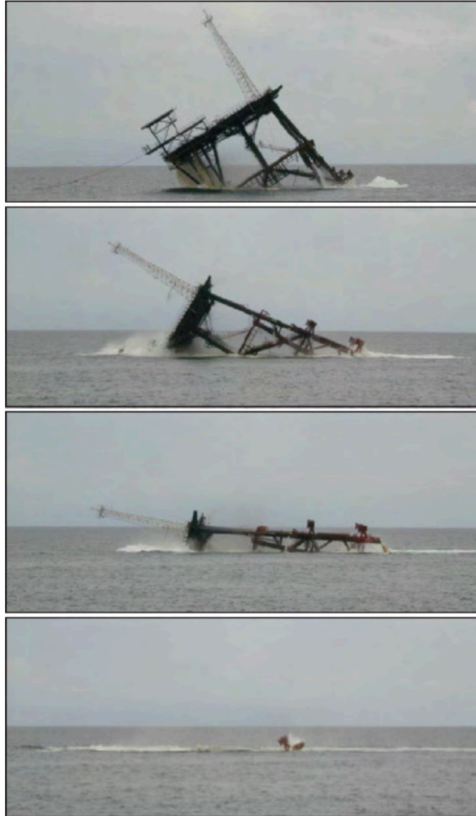
Figura 5.6-6 Hundimiento de una plataforma en el Golfo de México para ser usada como arrecife artificial. (Tomado de Oilfield Review, Schlumberger 30 , 2007).
