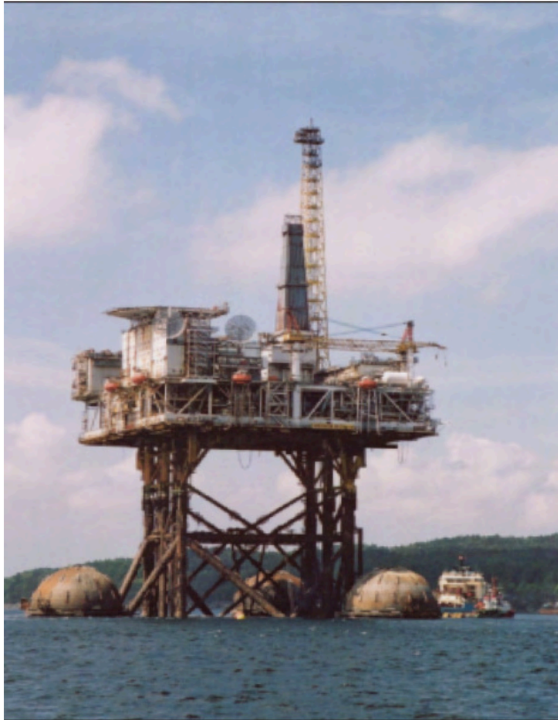
Figura 5.6-4 Plataforma Maureen reflatada y remolcada hacia una nueva localización. (Tomado de Oilfield Review, Schlumberger 30 , 2007).
