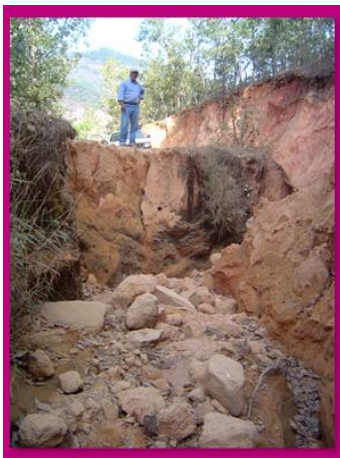
Figura 2. Desprendimiento de un banco de Material
