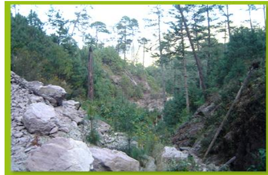
Figura 3. (Derrumbes y/o talud carcavamiento)
