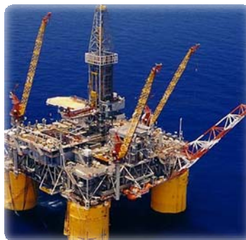
Fig. 1.10 Plataforma TLP "Ram Powell", en el Golfo de México
