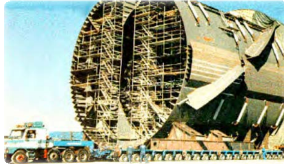
Fig. 1.13 Construcción de una plataforma “Spar”
