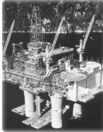
Fig. 1.9 Posicionamiento de la cubierta sobre la estructura de concreto.
