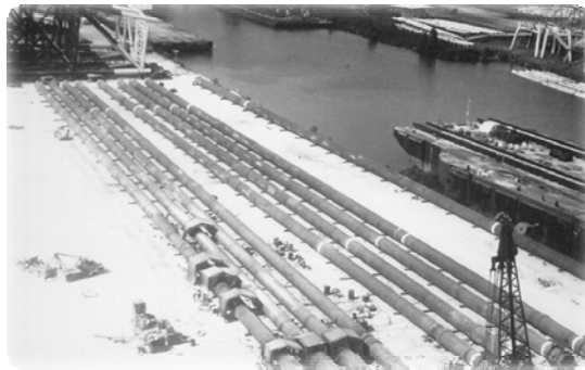
Fig. 1.7 Pilotes fabricados para una plataforma en el Golfo de México
