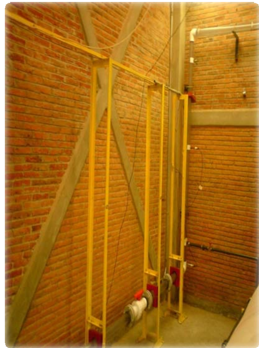
Fig. 6.3 Tubería ascendente vertical (“riser”)
