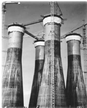
Fig. 1.8 Construcción de una plataforma de concreto en Noruega
