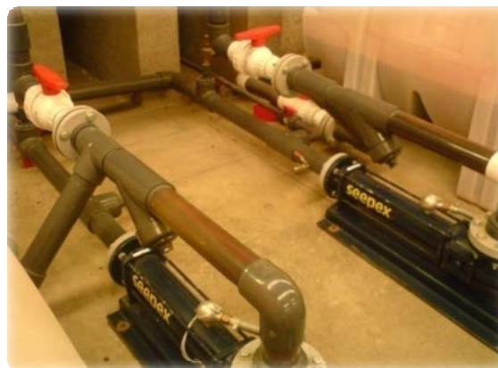
Fig. 6.12 Bombas de cavidades progresivas
