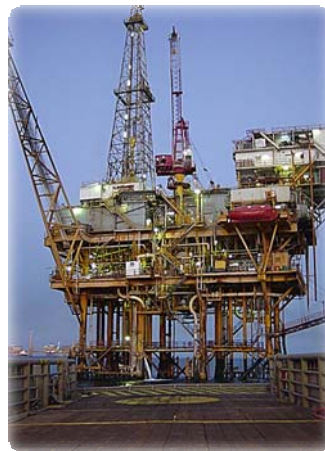
Fig. 1.6 Plataforma de acero en Cantarell
