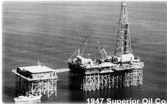
Fig. 1.3 Primer plataforma de acero, instalada en el Golfo de México.
