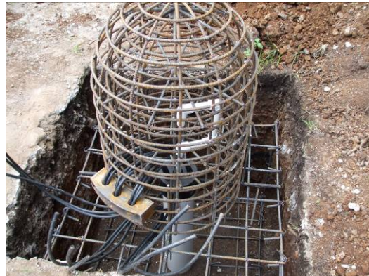
Figura 355: Instalación de la estructura metálica
