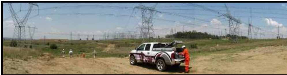
Figura 10: Ejemplo de cruzamiento del DDV con líneas de alta tensión
