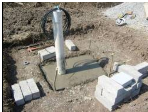
Figura 30: Arreglo de encamisado, ánodos y tubo de venteo
