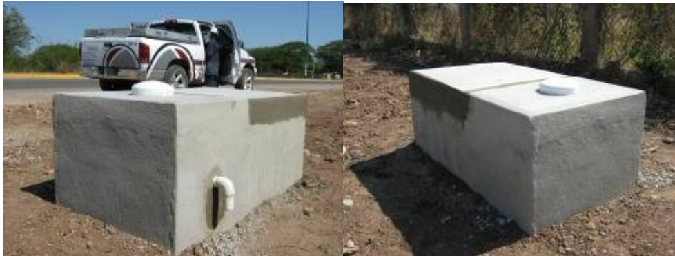
Figura 33: Encofrado mostrando el tubo de venteo
