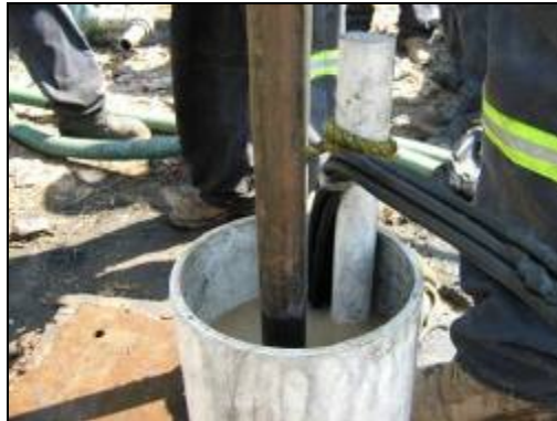
Figura 30: Arreglo de encamisado, ánodos y tubo de venteo
