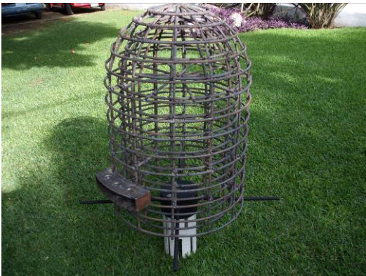
Figura 344: Doble Estructura metálica del encofrado
