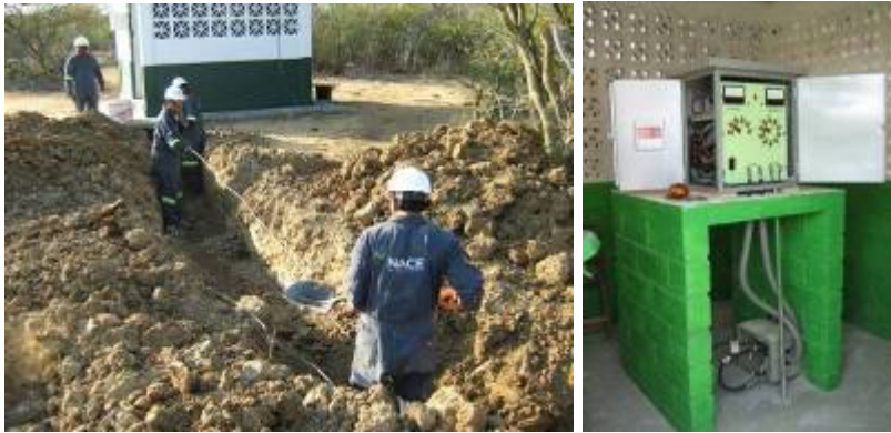
Figura 32: a) Conexión de la cama anódica al rectificador, b) Caseta de rectificador
