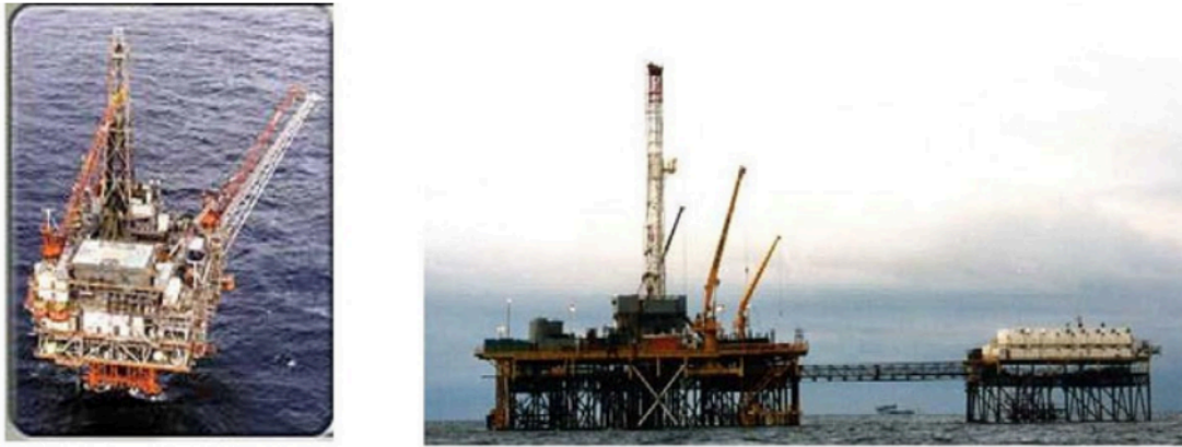
Figura 4.5 plataforma fija autosuficiente.
