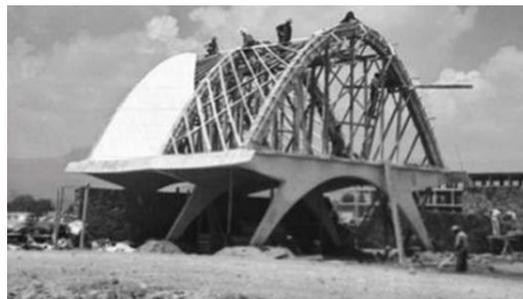
Figura 2.1 Construcción del Pabellón de Rayos Cósmicos [24]
