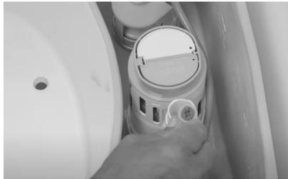
Figura 36. Interior del tanque con el dispositivo para la doble descarga del inodoro (Home Depot, 2022).
