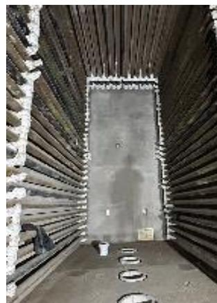
Figura 4.11A. Limpieza posterior al lanzado. Fuente: Propia.
