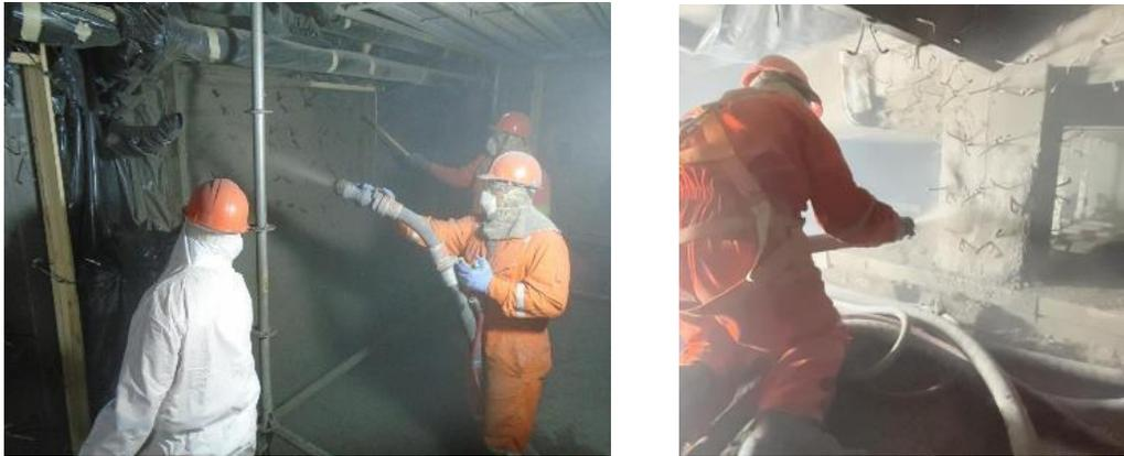
Figura 4.2. Lanzado de concreto refractario en sitio. Fuente: Propia.
