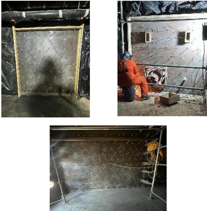
Figura 3.5. Anclas instaladas en paredes verticales. Fuente: Propia.
