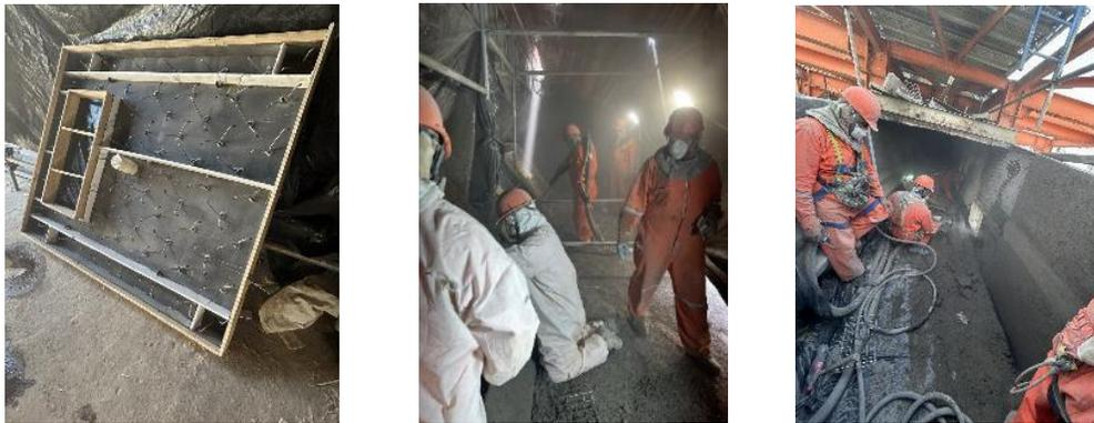
Figura 4.12A. Preparación y lanzado de refractario en paredes de convección. Fuente: Propia.
