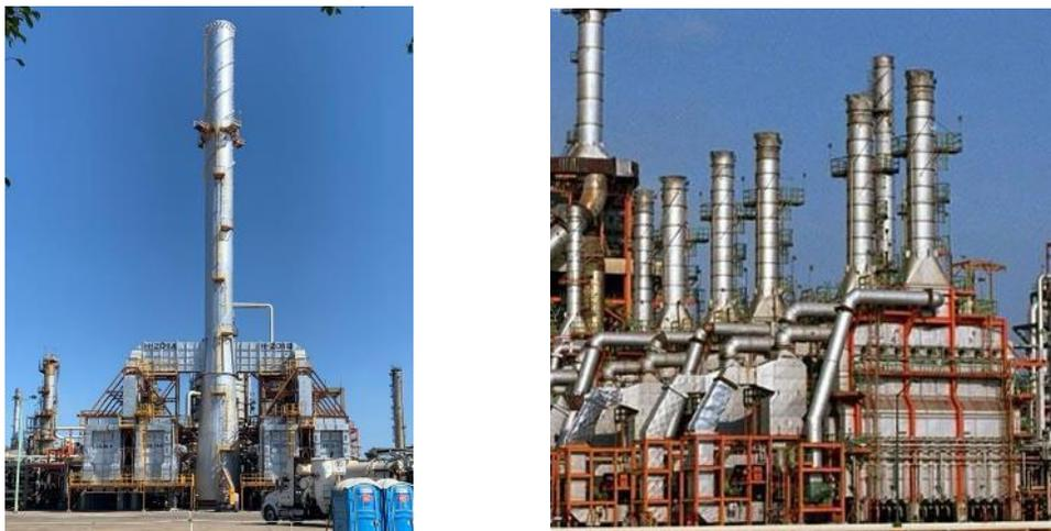
*Figura 1.3 Calentadores de carga térmica media. Planta de Alto Vacío en Salina Cruz (izquierda) y Calentadores de la planta Hidrodesulfuradora II en Tula. Fuente: Propia*
