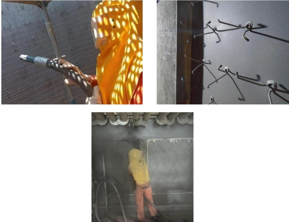
Figura 3.20. Aplicación de sand blast en interior de envolvente y chimenea. Fuente: Propia.
