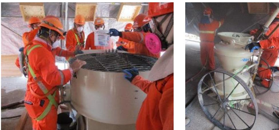
Figura 4.1. Premezclado de concreto refractario. Fuente: Propia.
