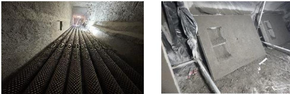
Figura 4.12B. Concreto refractario en paredes de convección. Fuente: Propia.
