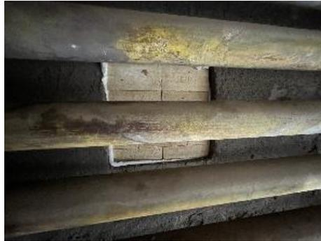
*Figura 4.17. Ladrillo refractario en entradas hombre y ventanas de explosión. Fuente: Propia.*
