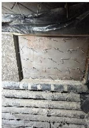
Figura 4.11B. Placa previa a ser lanzada. Fuente: Propia.
