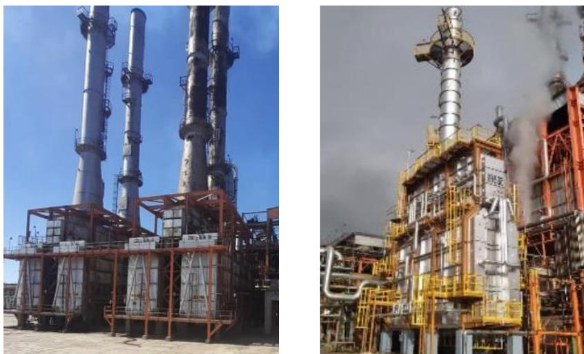
*Figura 1.1 Calentadores atmosféricos en la planta Combinada No. 1 (Izquierda) y calentador de la planta Hidrodesulfuradora No. 2 (derecha). Fuente: Propia*
