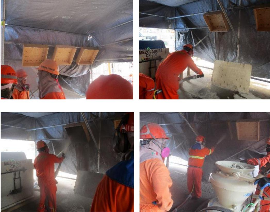
Figura 4.3. Prueba de instalación de concreto refractario. Fuente: Propia.
