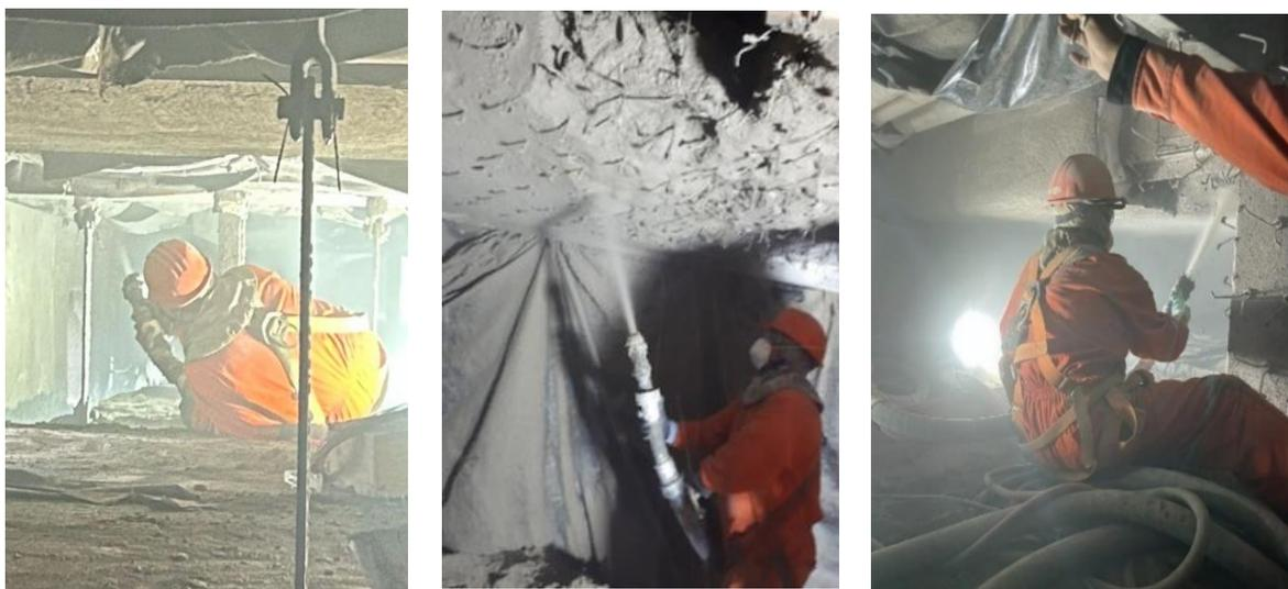
Figura 4.13. Concreto refractario lanzado en techos. Fuente: Propia.
