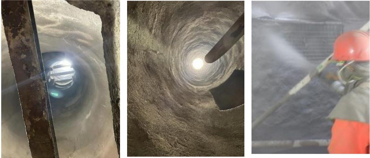
Figura 4.15. Concreto refractario lanzado en chimenea. Fuente: Propia.
