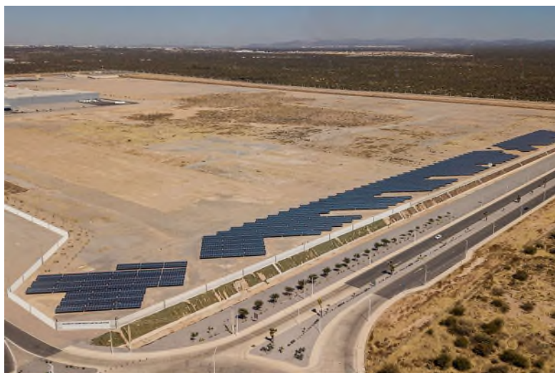
Figura 13. Paneles Solares en Planta BMW San Luis Potosí.
