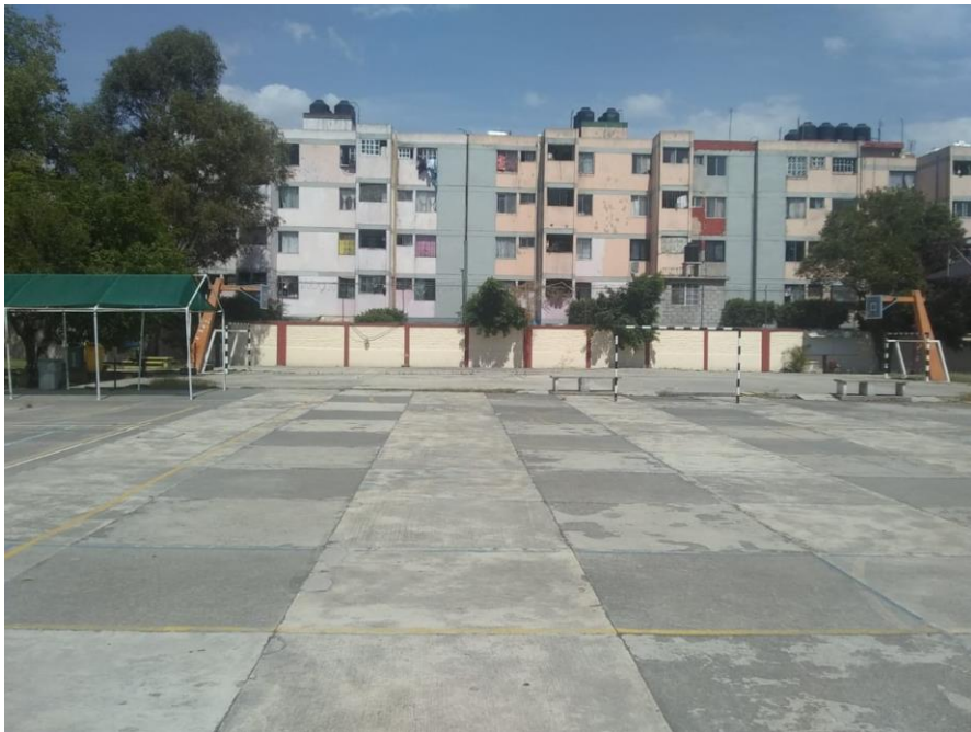
Imagen 2 Vista del espacio donde se construye el arco techo.
