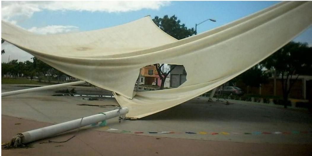
Figura 5. Falla en material textil
