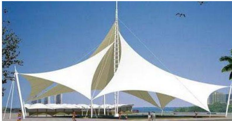
Figura 3. Tensoestructura de membrana.
