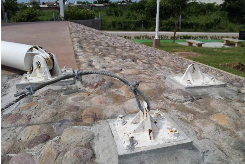
Figura 6. Colapso de elemento de soporte
