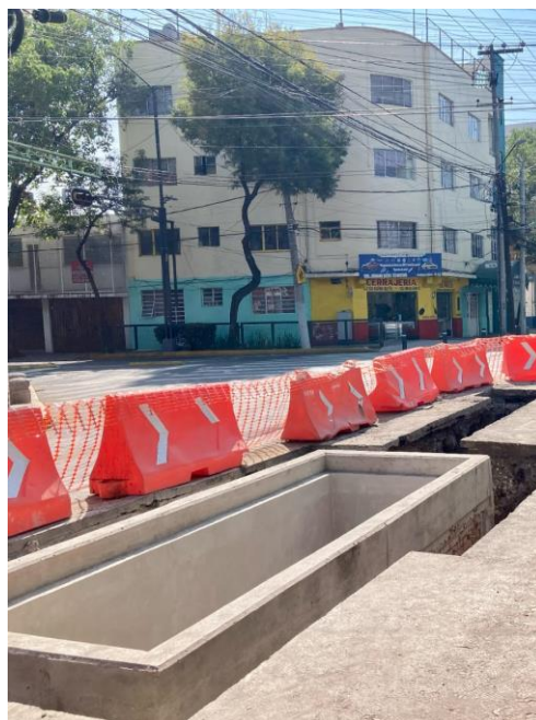
Figura 2. Construcción de caja de medición y control. Elaboración propia.
