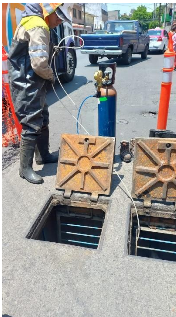
Figura 25. Retiro del tanque e inyector a la entrada al sector. Elaboración propia.
