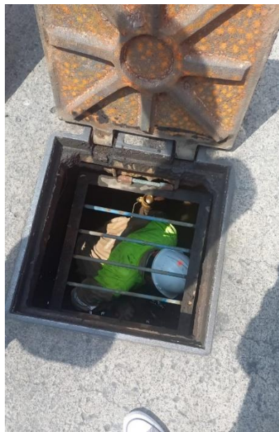
Figura 16. Trabajadores que colocarán el inyector. Elaboración propia.
