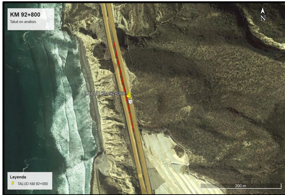
Figura 1. Talud KM 92+800 en estudio.
