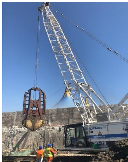
Figura 13. Excavación por medio de almeja de caída libre
