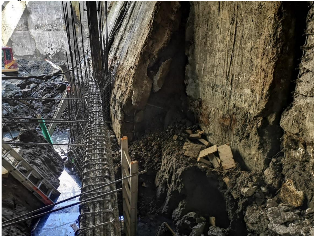
Figura 22. Zanja realizada para la construcción de la trabe de liga.
