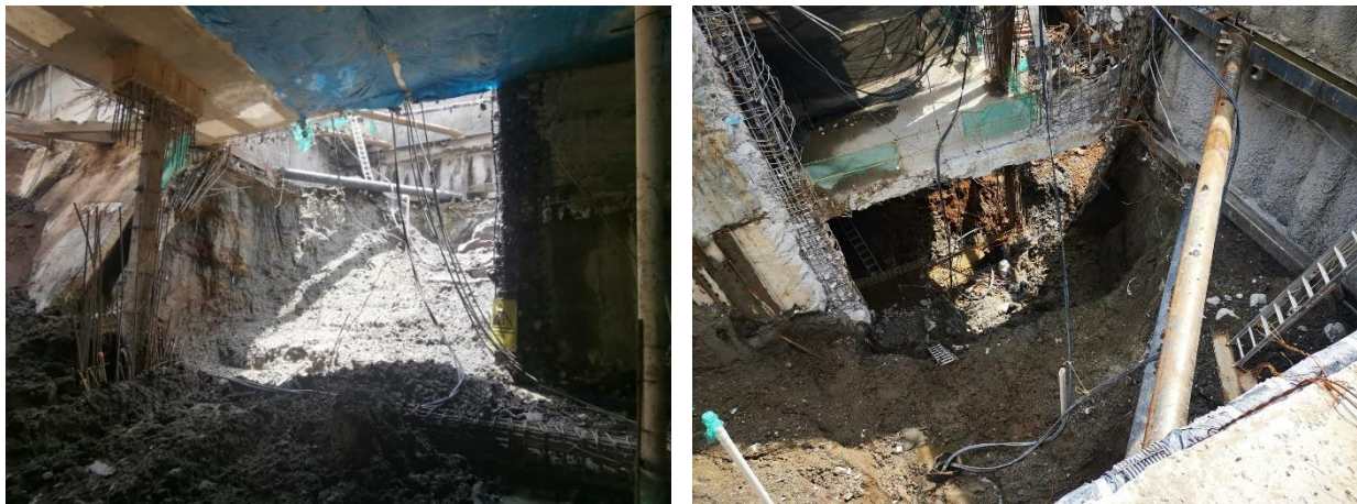
Figura 34. Excavación del área de trabajo dejando la berma perimetral
