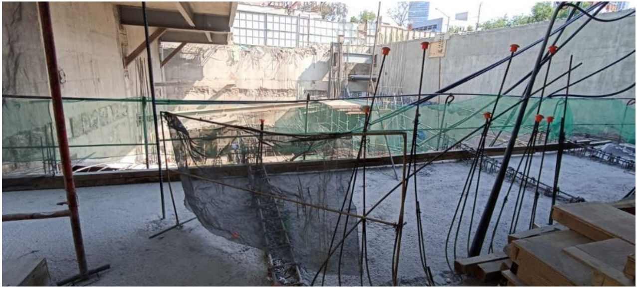
Figura 15. Apuntalamiento con losa de entrepiso
