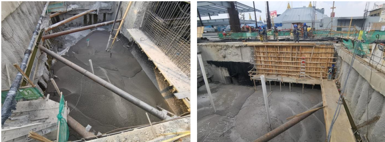
Figura 38. Relleno de la excavación temporal
