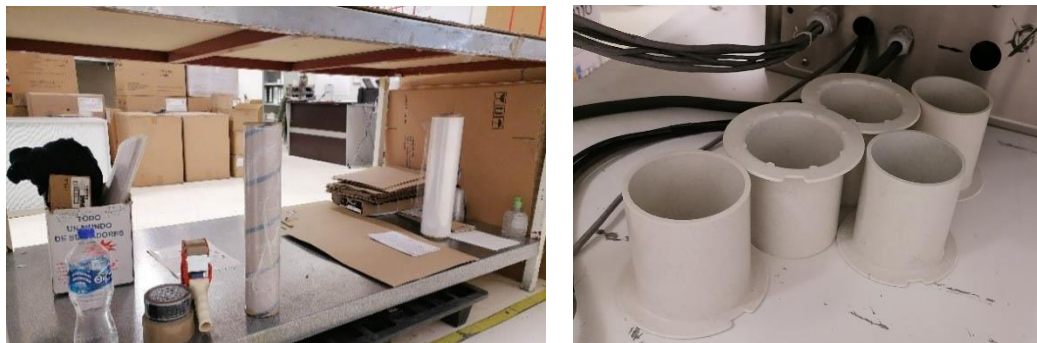
Fig. 30. Estado inicial de la estación de Limpieza y empaque del área de filtros absolutos
