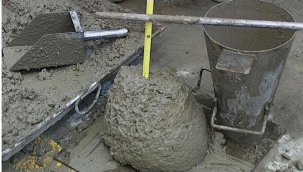
Figura 7 Muestreo en Obra (Revenimiento)
