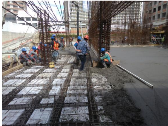
Figura 6 Concreto reforzado en obra
