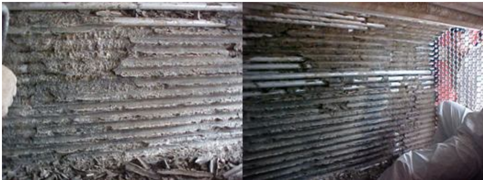
Figura 1.9 Generación de incrustaciones en la evaporadora de agua de mar MVC. (Planta Termoeléctrica de Rosarito, Baja California Sur)
