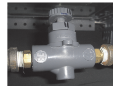
Figura 2.5: Válvula de aguja.
