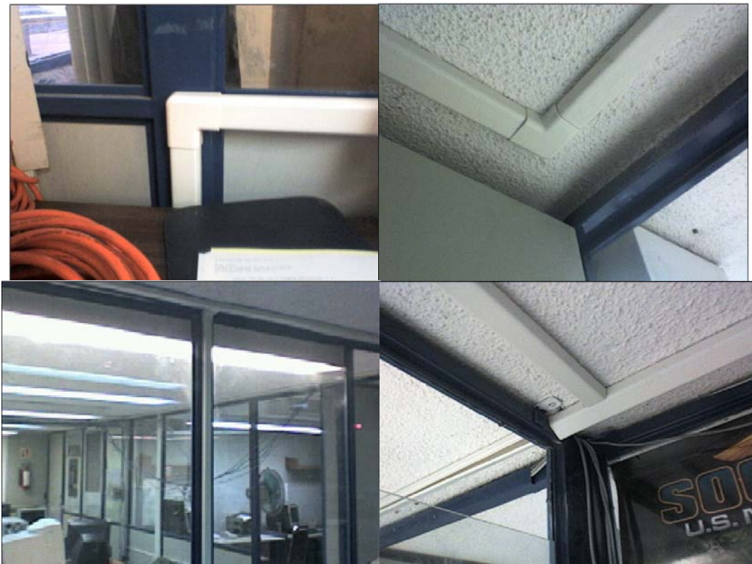
Fig. 3-3 Instalación de canaleta
