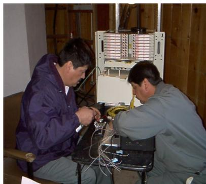
Closet de telecomunicaciones habilitado con 6 pares de fibra óptica instalada y funcionando localizado en el edificio del telescopio de 84 cm.
