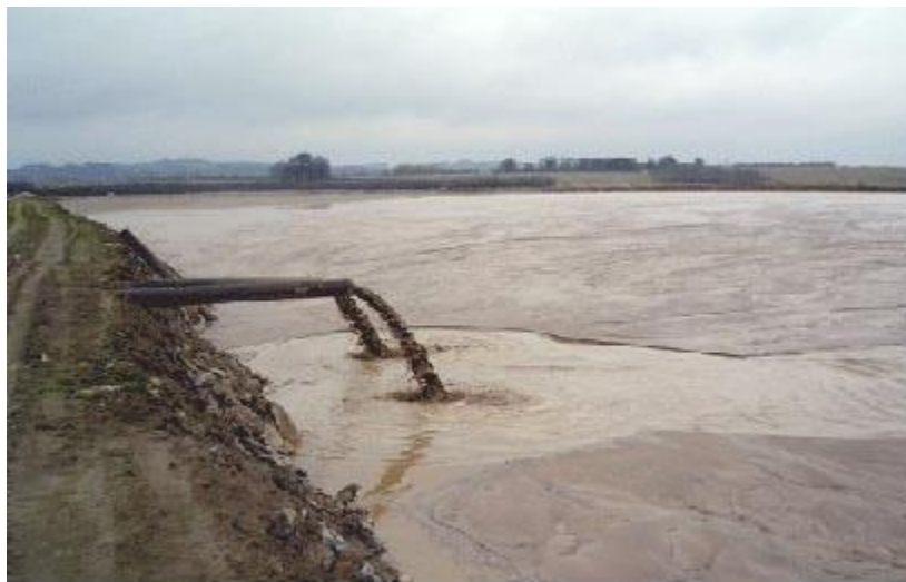
Figura 1.7 Un solo punto de descarga en Glebe Mines, England (Engels, 2020).
