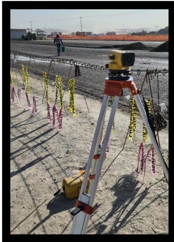
**Colocación de estacas en el área destinada para el estacionamiento para así realizar cálculo de pendientes mediante el método “metro por metro” (imagen inferior)**
