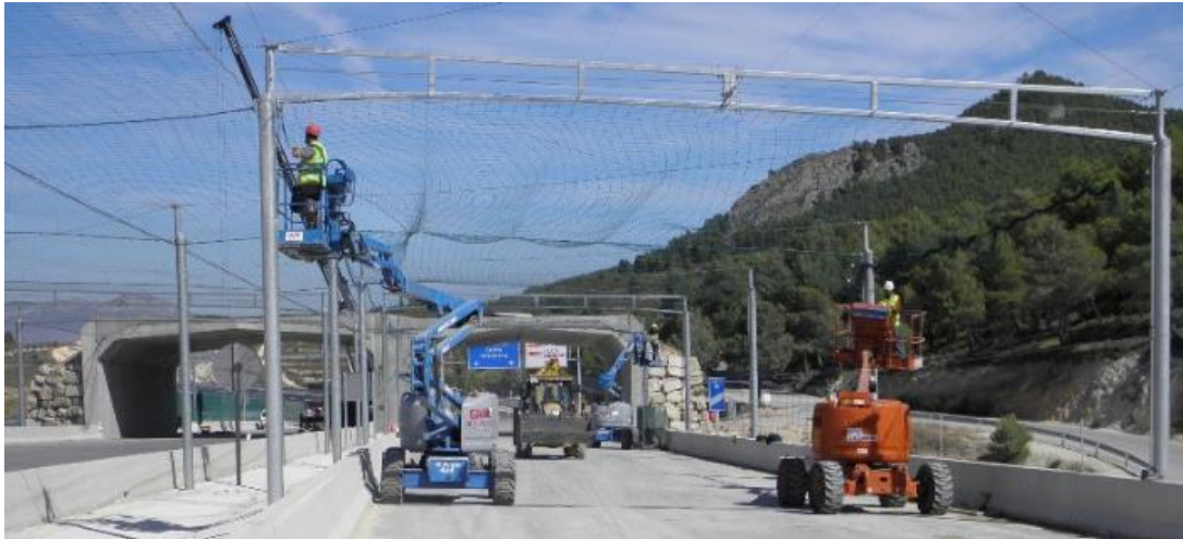
Figura 24 Colocación de malla que limita el vuelo de aves y murciélagos a ras de la corona de la infraestructura lineal
