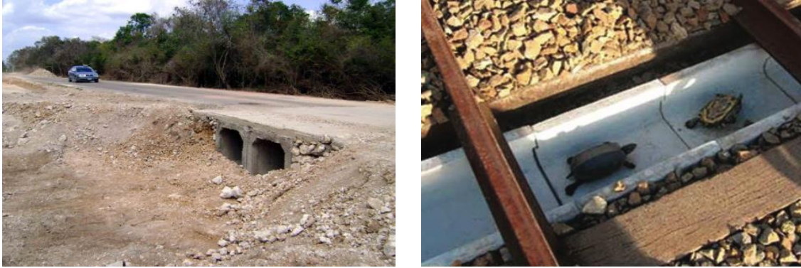
Figura 14 Ejemplos de pasos para fauna embebidos en la infraestructura para el cruce de anfibios y reptiles
