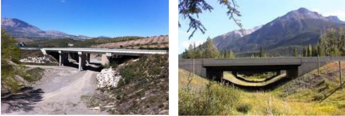
Figura 8 Puente carretero, ferroviario y losa funcionando como Paso Superior para Fauna (PSFA)
