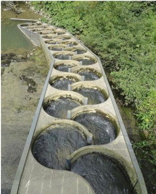
Figura 29 Ejemplos de la colocación de elementos que permiten el movimiento de peces en ambos sentidos cuando el río lleva poco caudal de agua o bien
