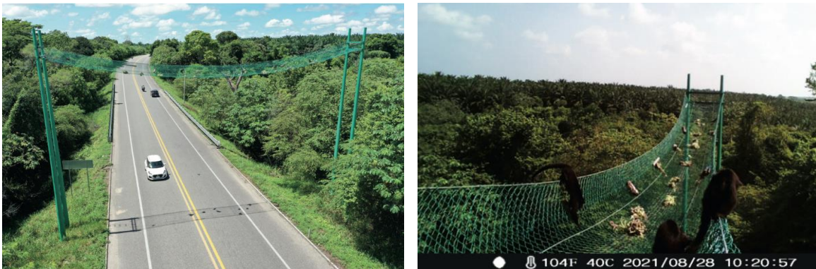
Figura 19 Paso para fauna arborícola a base de pasarelas con malla recubierta de plástico
