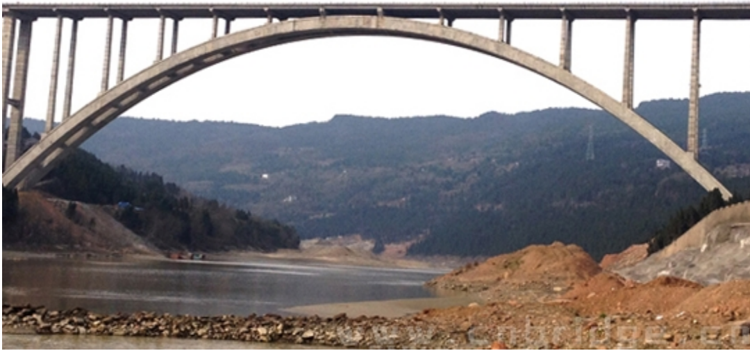
Figura 53 . Puente Zhaohua sobre el río Jialing, Sichuan, China.
