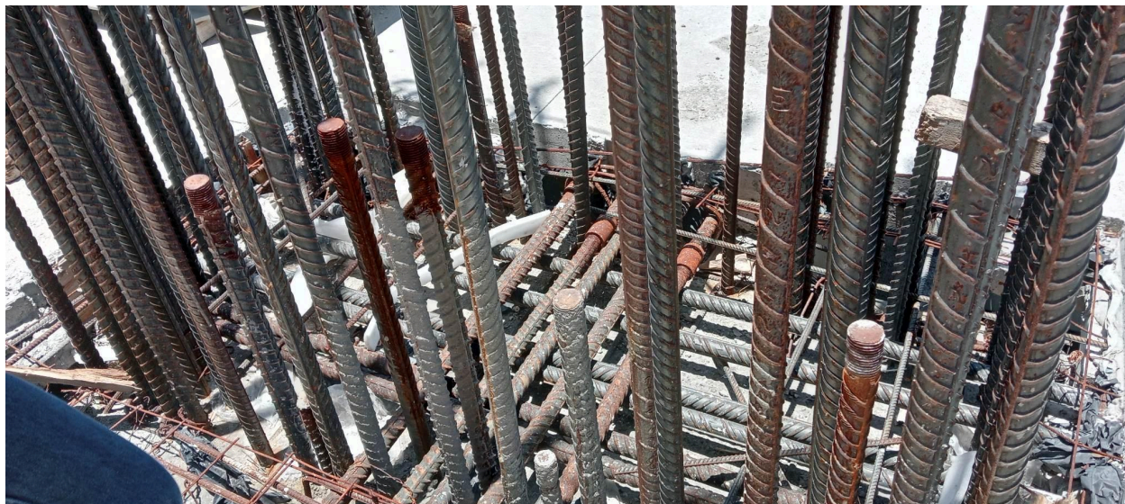
Figura 82. Armado de acero de refuerzo en nodo de una columna.
