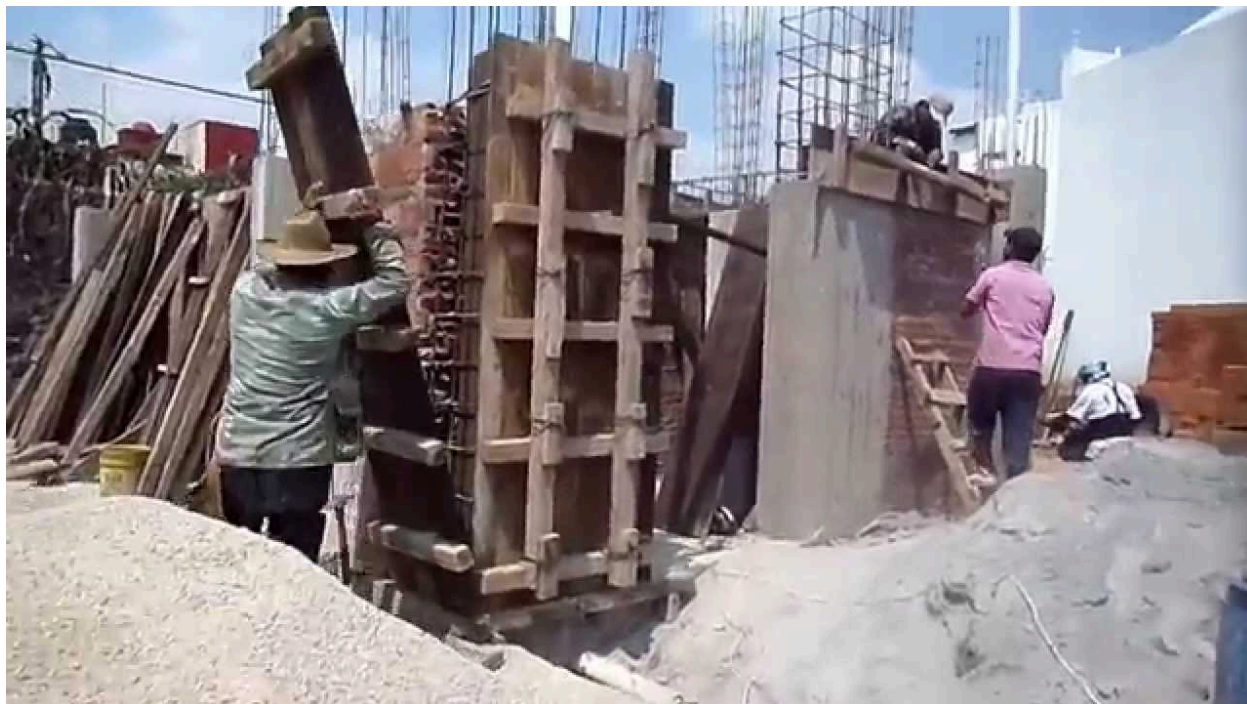
Figura 54. Colocación de cimbra de madera para columna cuadrada.
