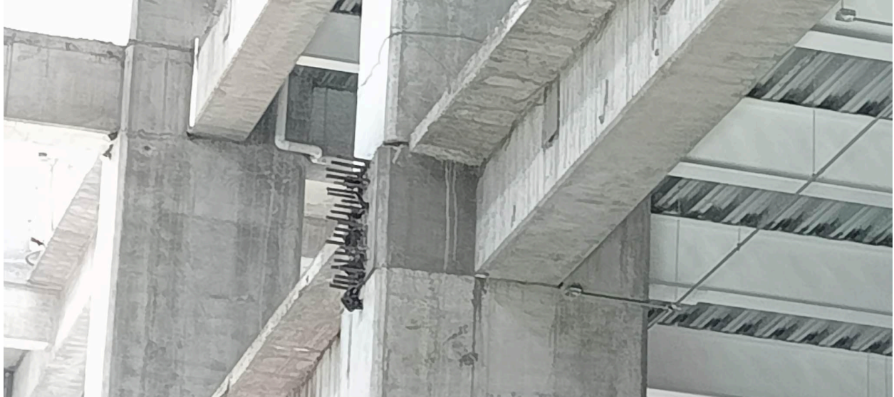
Figura 72. Nodo de entrepisos con columnas terminadas y preparación para unión viga-columna.
