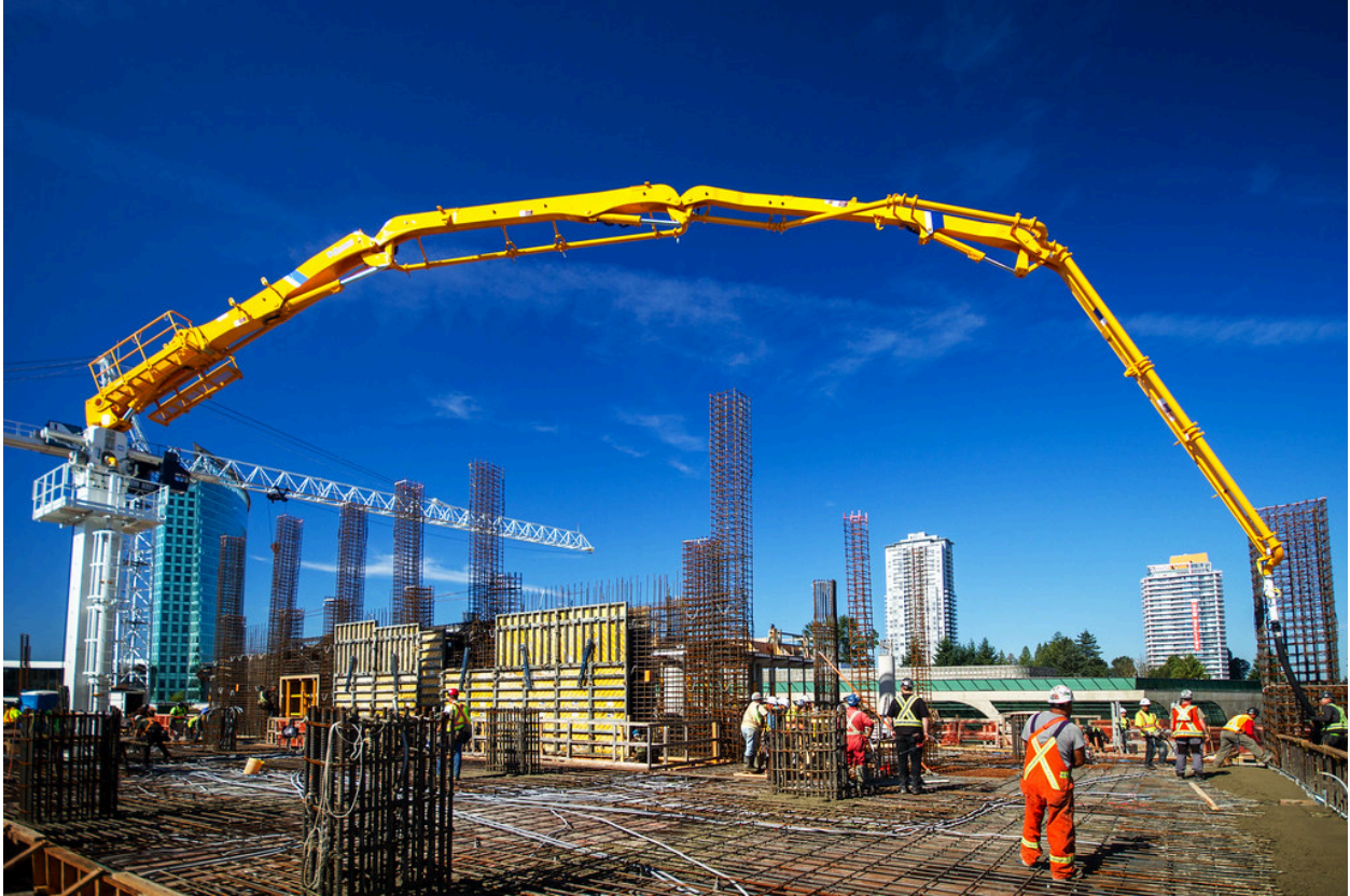
Figura 57. Placing-Boom en colado.
