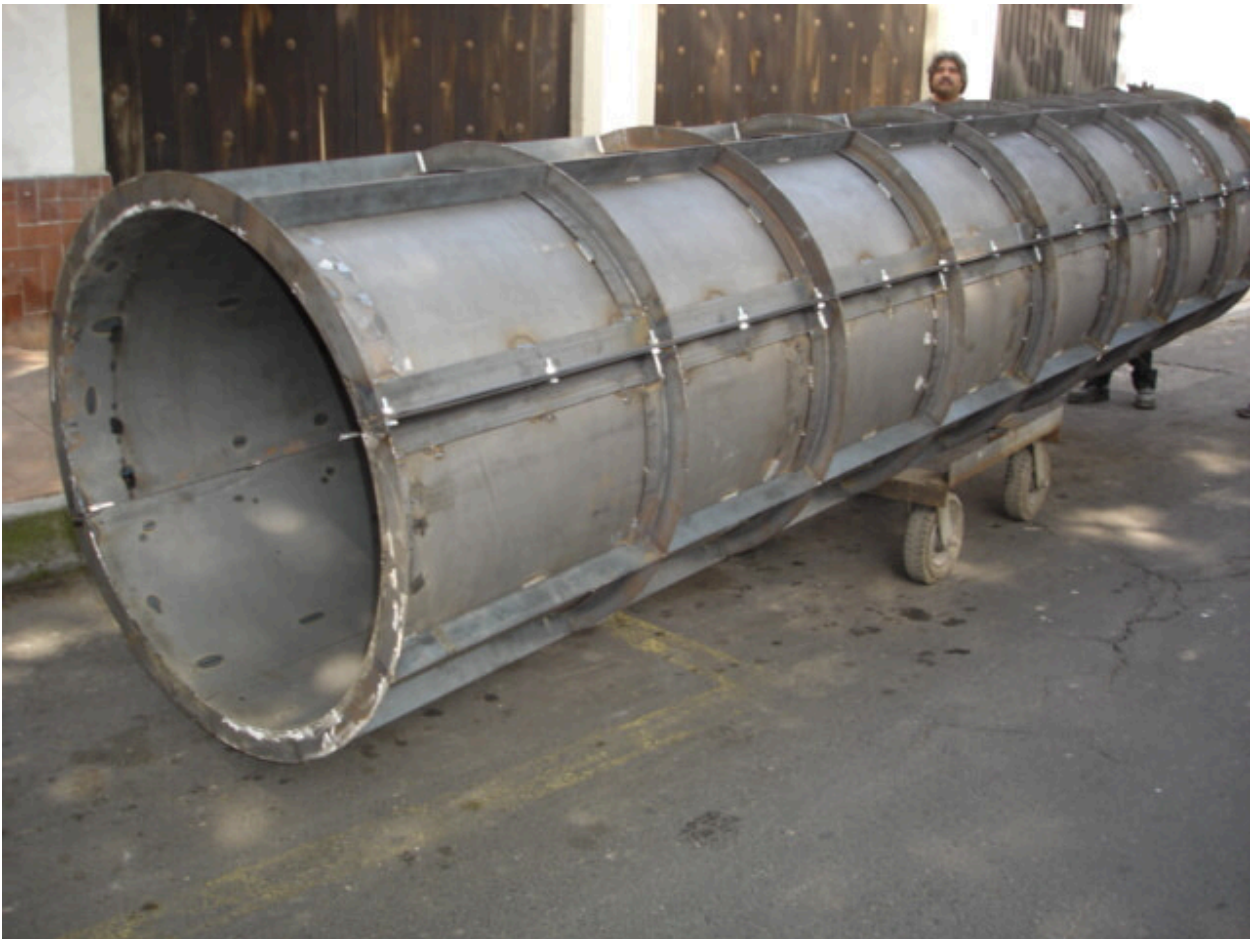
Figura 20. Cimbra metálica para columna de área transversal circular.
