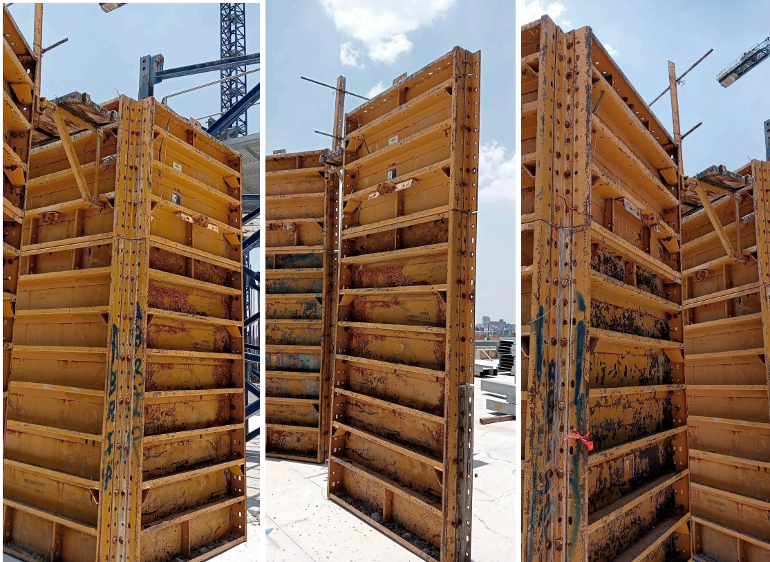
Figura 88. Cimbra metálica utilizada para las columnas.
