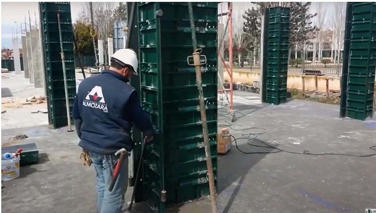
Figura 23. Colocación del plomo y apuntalamiento en cimbra metálica
