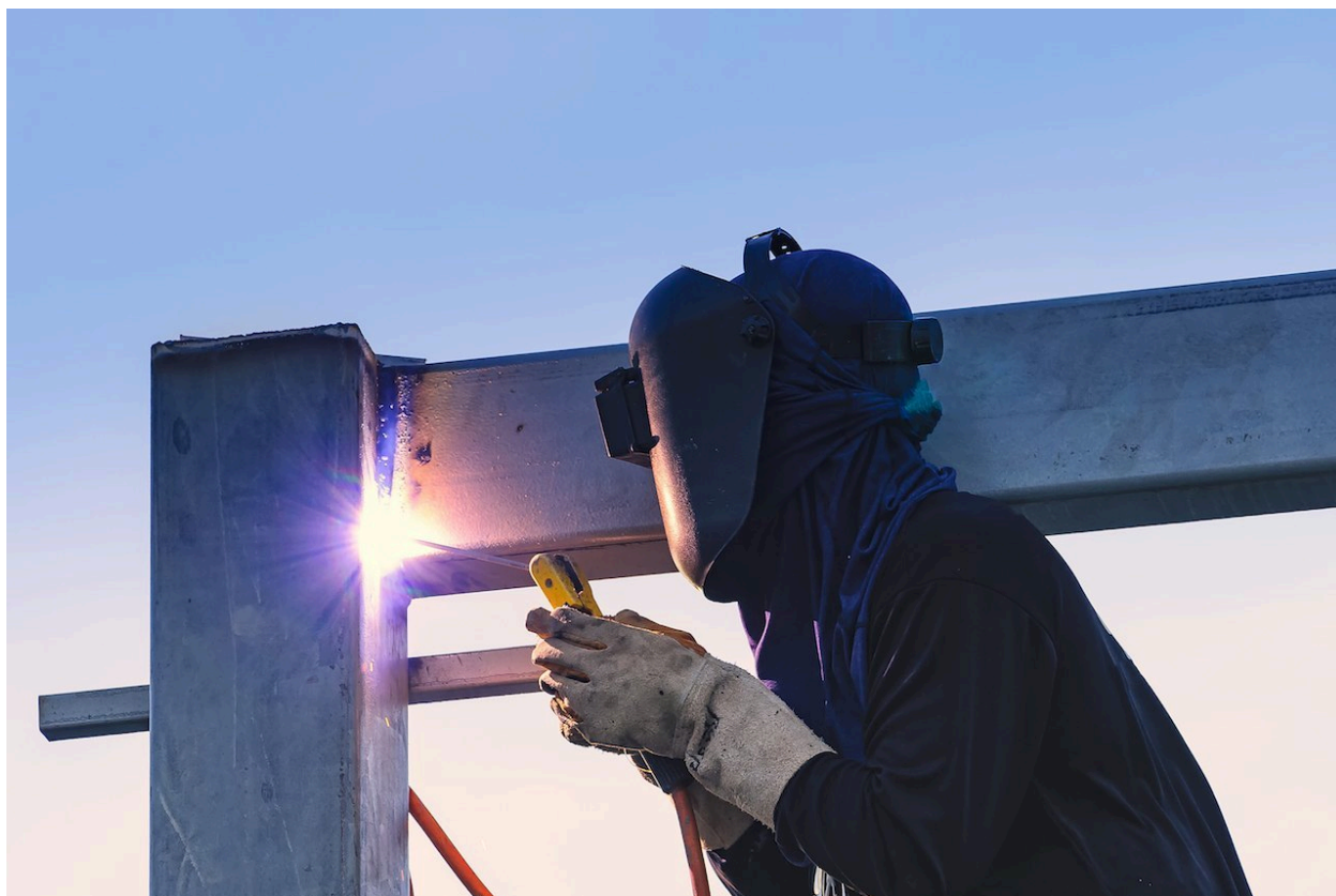
Figura 62. Soldadura de dos perfiles de acero.
