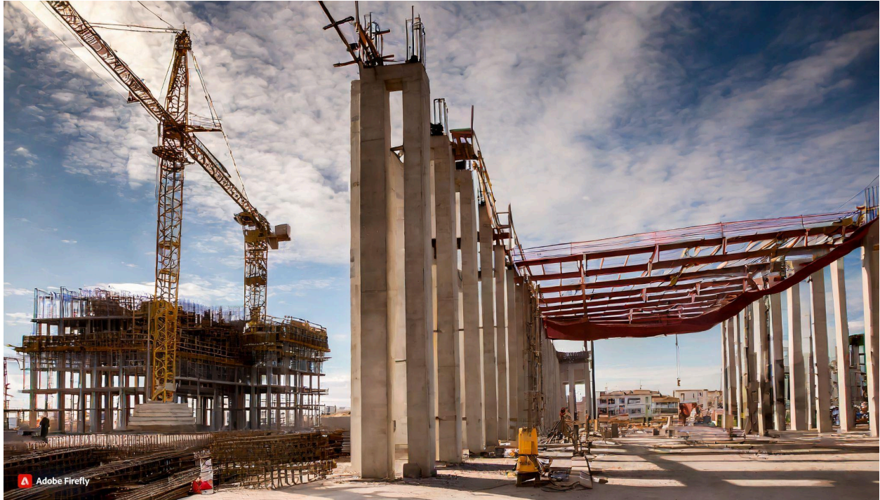
Figura 2. Proceso constructivo de columnas mixtas.
