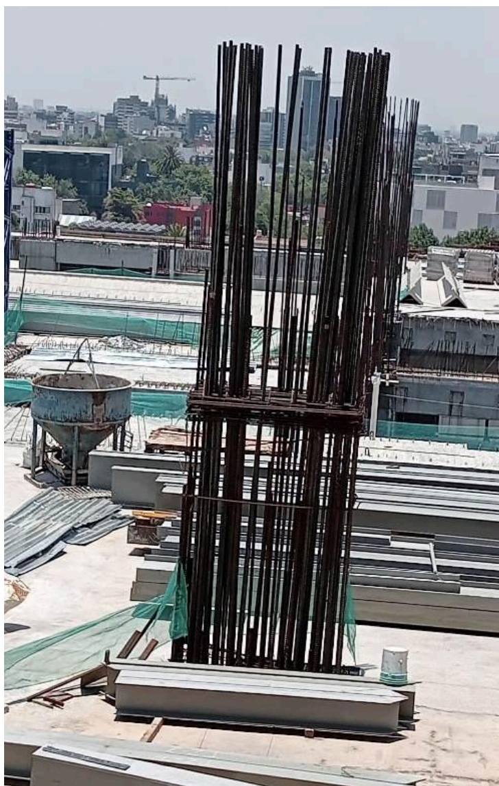
Figura 77. Acero de refuerzo en una columna mixta.
