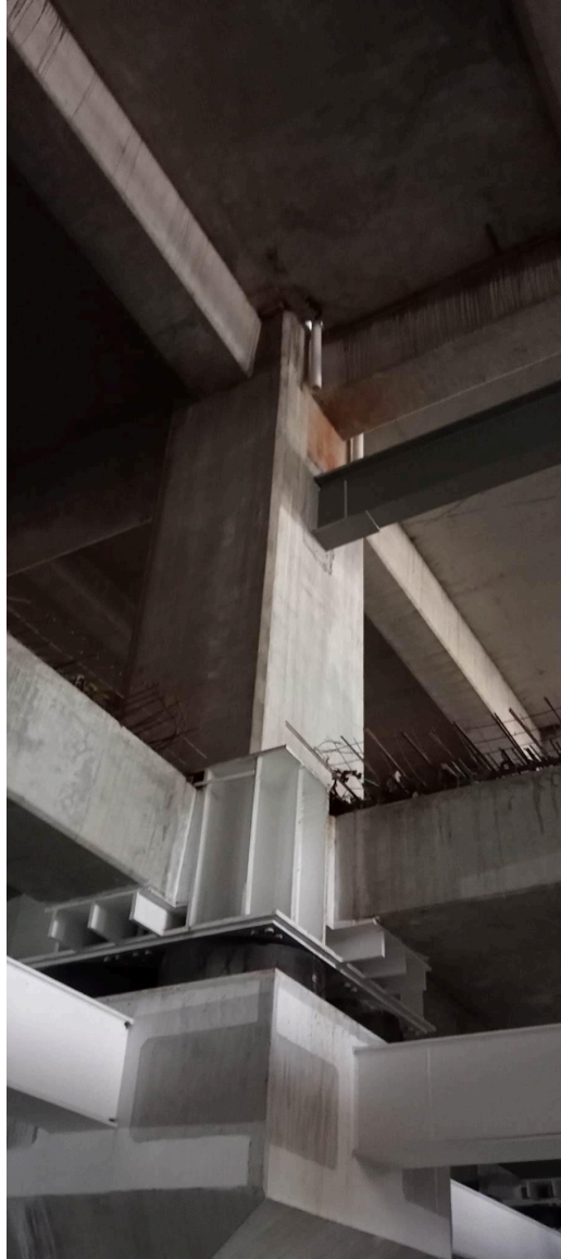
Figura 75. Columna terminada entre sótano 1 y planta baja.
