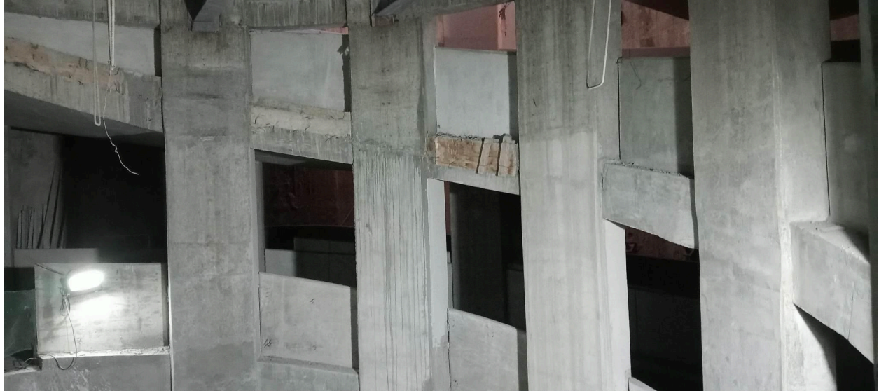
Figura 69. Columnas terminadas de los sótanos de estacionamiento.
