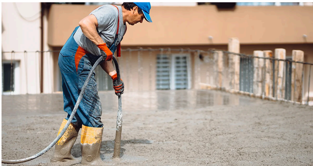
Figura 59. Vibrado de concreto en una losa.
