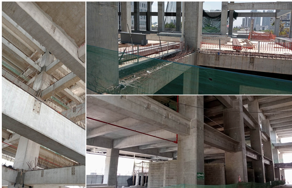
Figura 67. Columnas mixtas terminadas.
