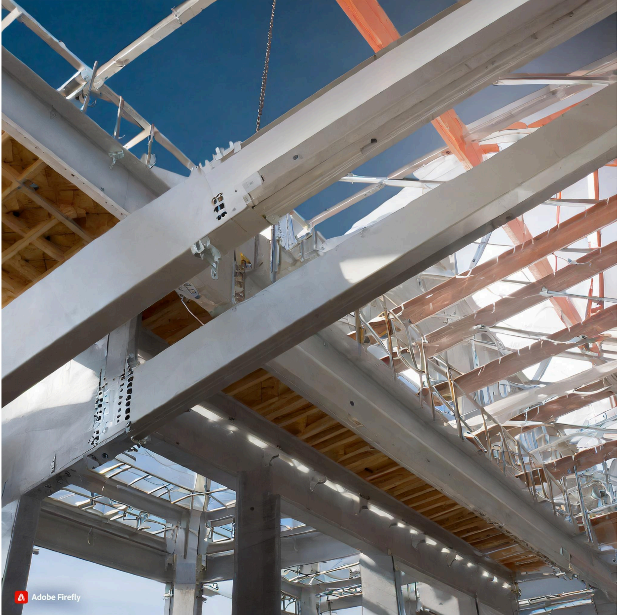
Figura 1. Estructuras compuestas en construcción.
