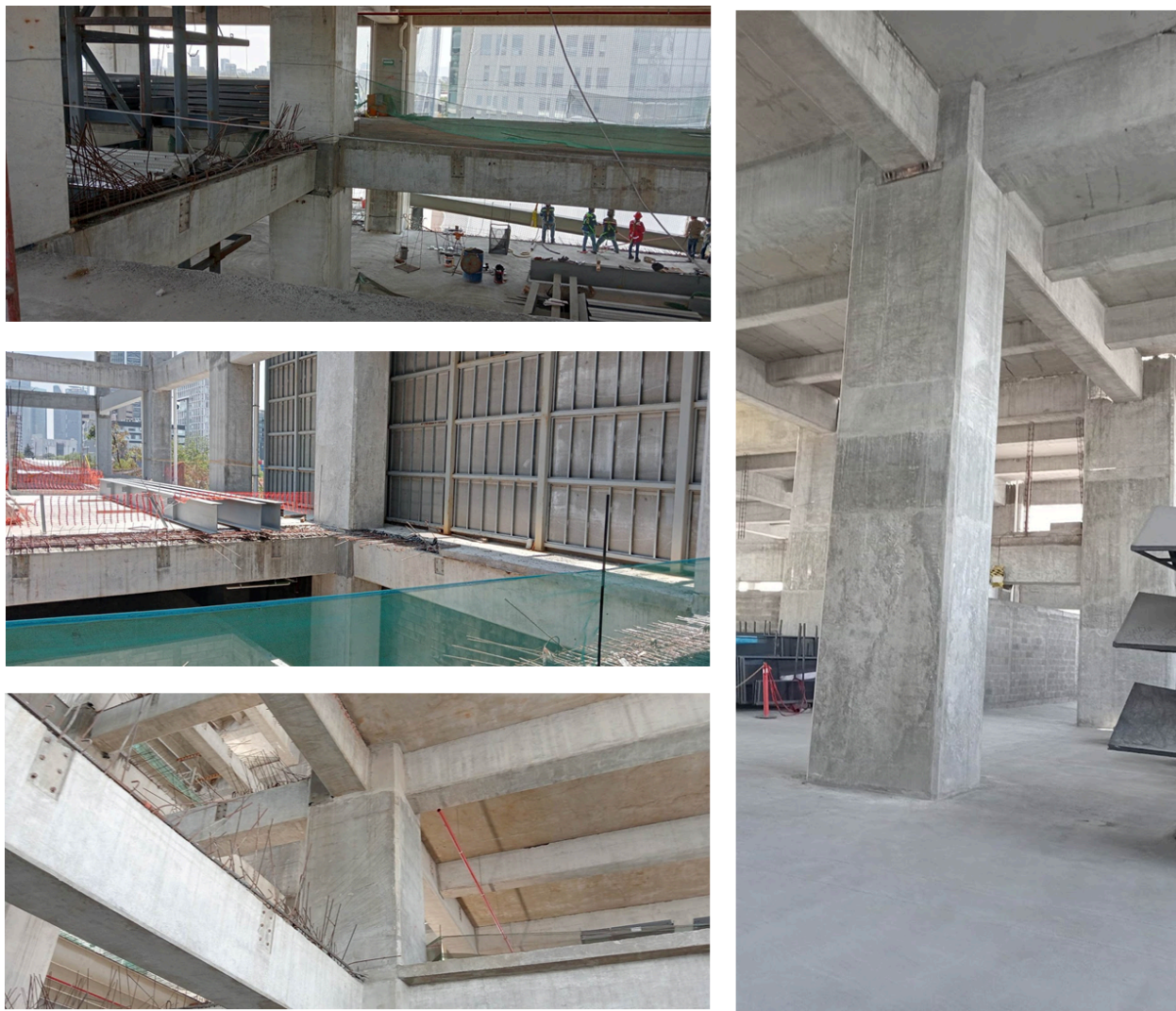
Figura 68. Columnas mixtas terminadas.
