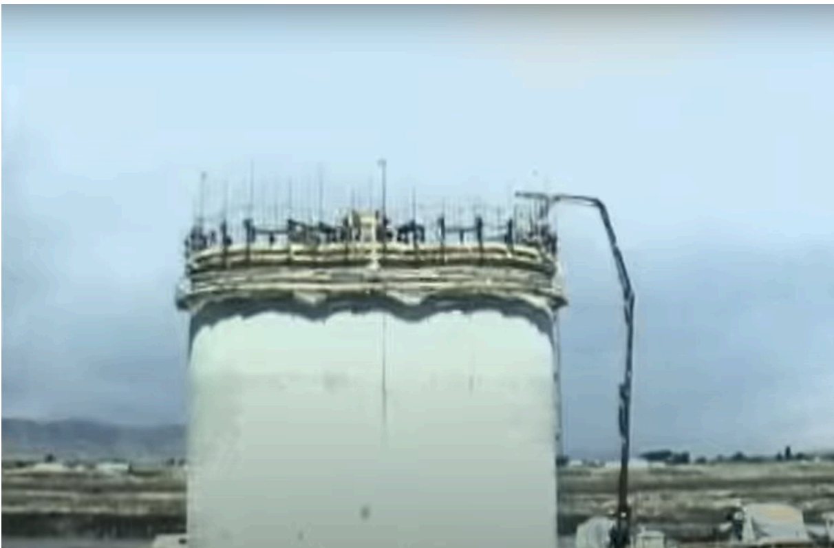
Figura 14. Cimbra deslizante en la construcción de un silo en el estado de Oregon, Estados Unidos. AVPMedia [@AVPMedia1]. (2010, Marzo 11). Slip-form construction time lapse - The Dalles, Oregon . Youtube. https://www.youtube.com/watch?v=G_6_5bZFILO
