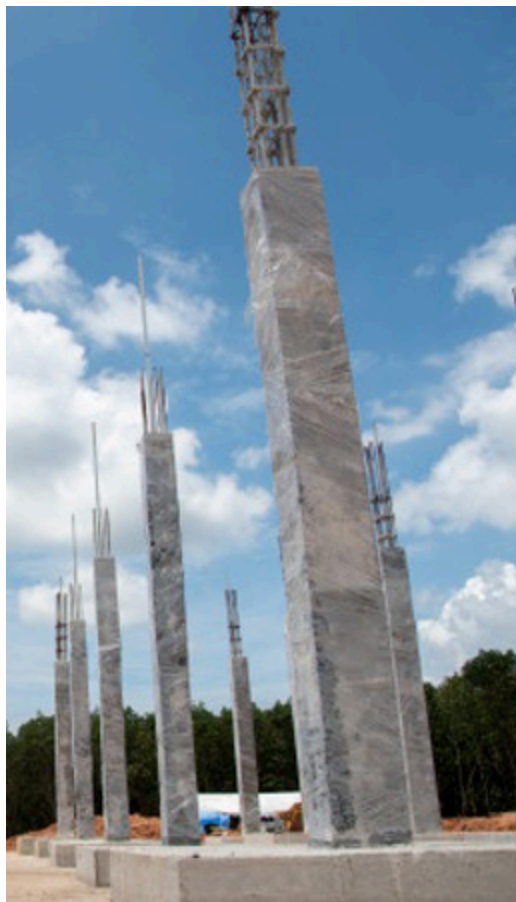
Figura 11. Columnas de concreto armado
