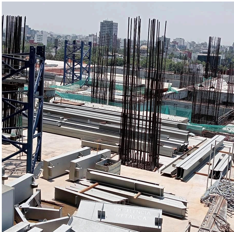
Figura 78. Armado de acero de refuerzo en columnas mixtas.
