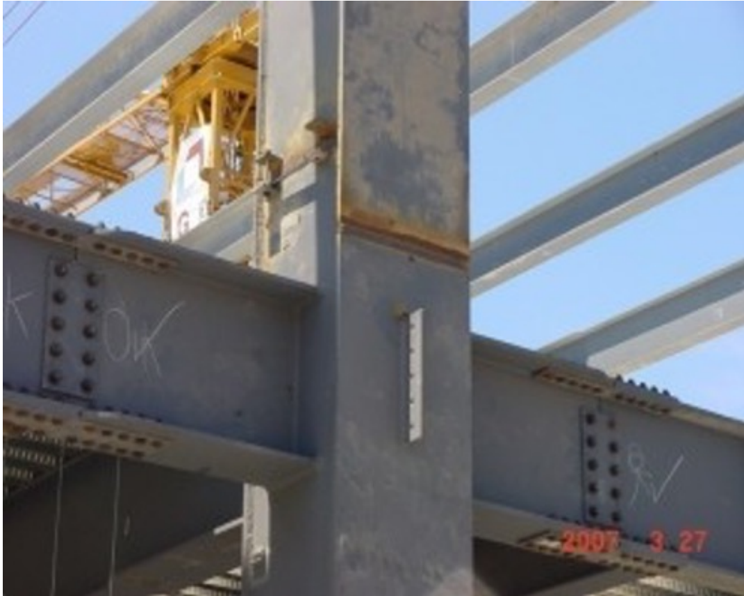
Figura 43. Conexión tipo árbol entre columna y viga
