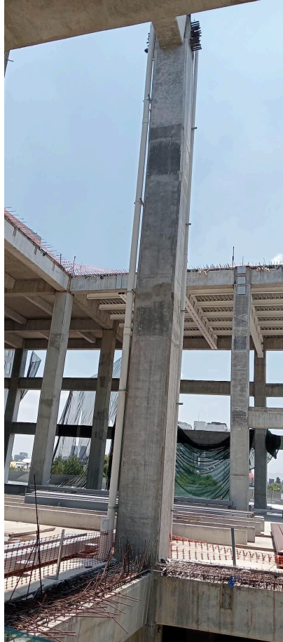
Figura 71. Columna terminada con altura de 3 entrespisos.
