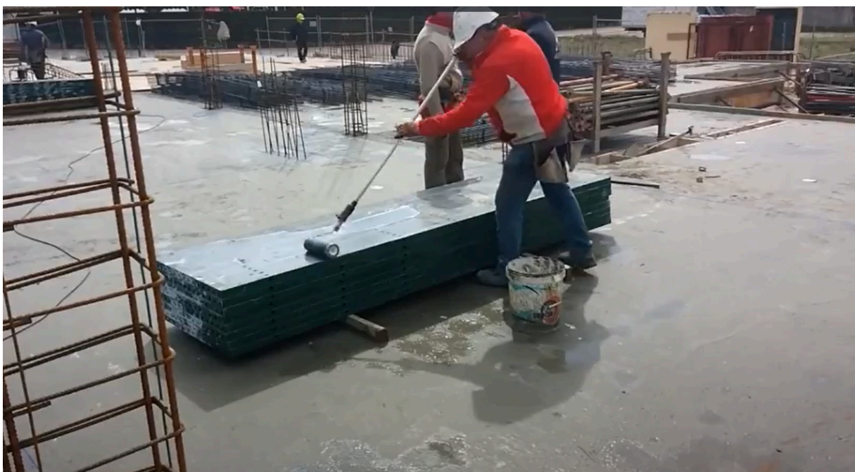
Figura 21. Impregnación de líquido desmoldante a la cimbra metálica de contacto para columna de área transversal cuadrada.
