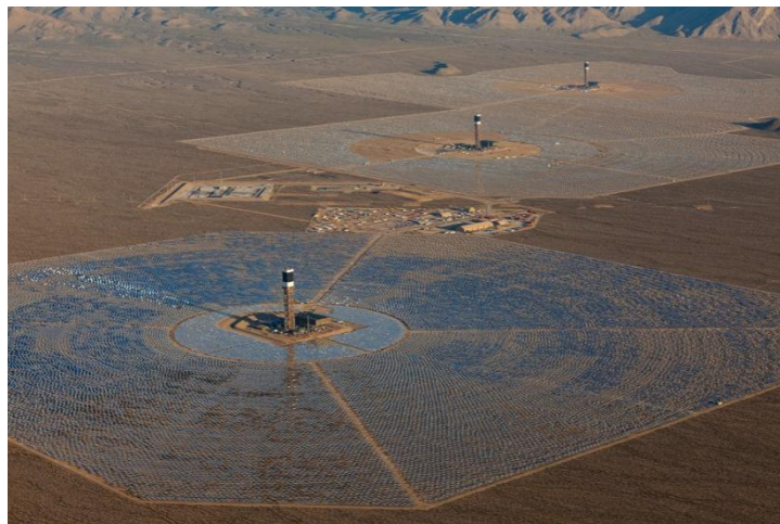
Figura 7. Planta solar Ivanpah [18]
